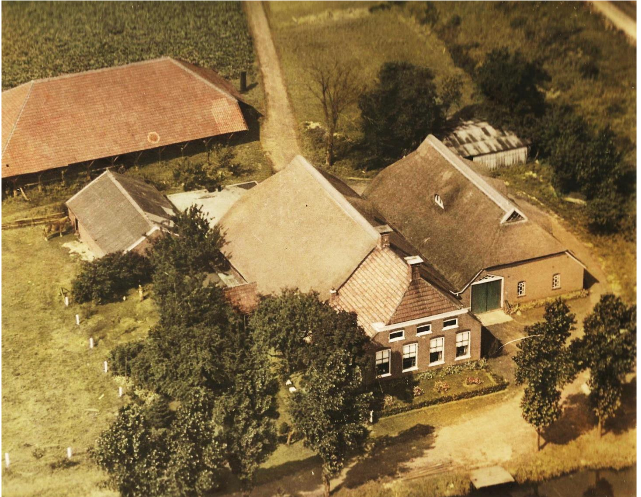
De boerderij is op houten palen gebouwd, het Amsterdamse systeem.
