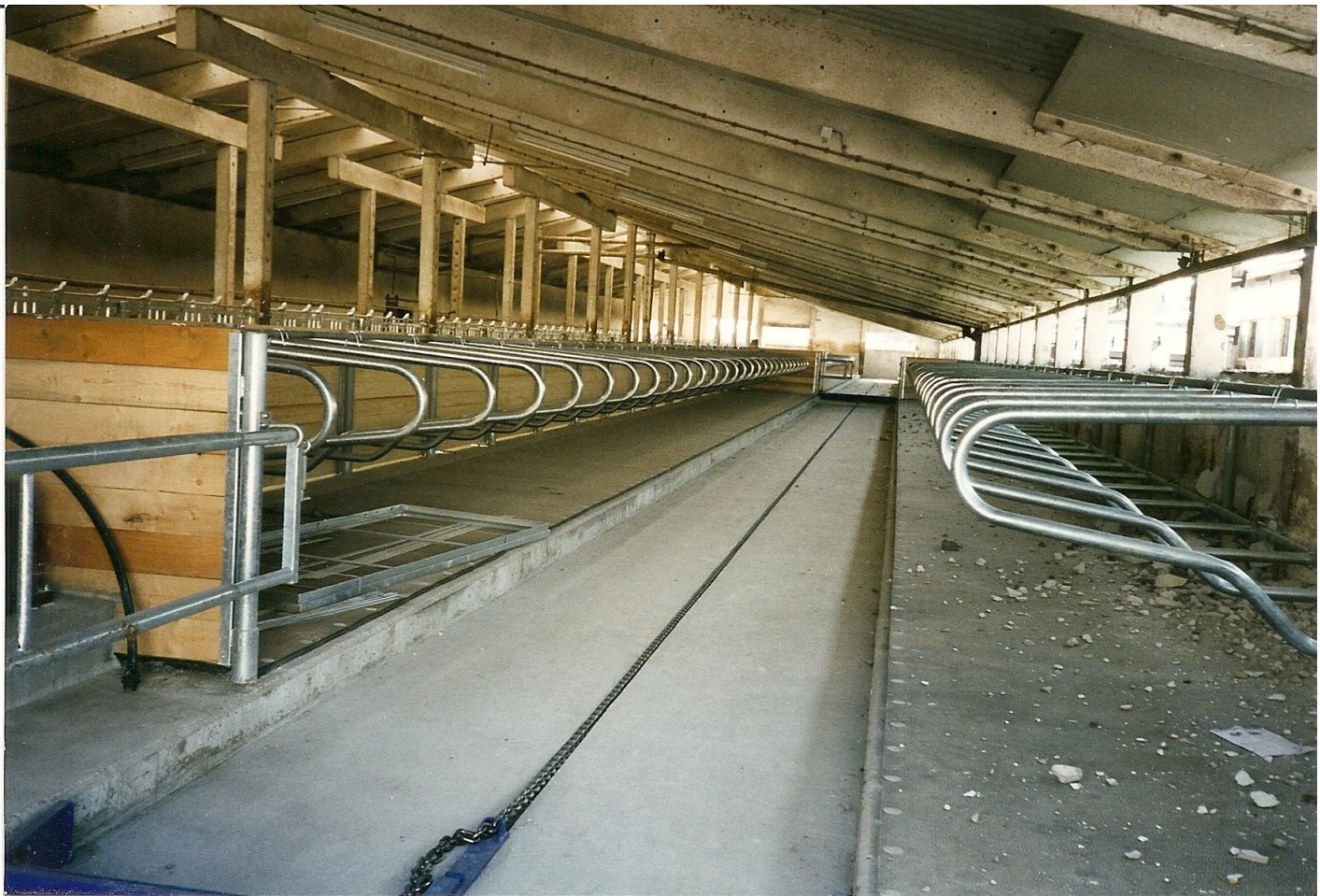
Stemmern verbouwde koeienstal
