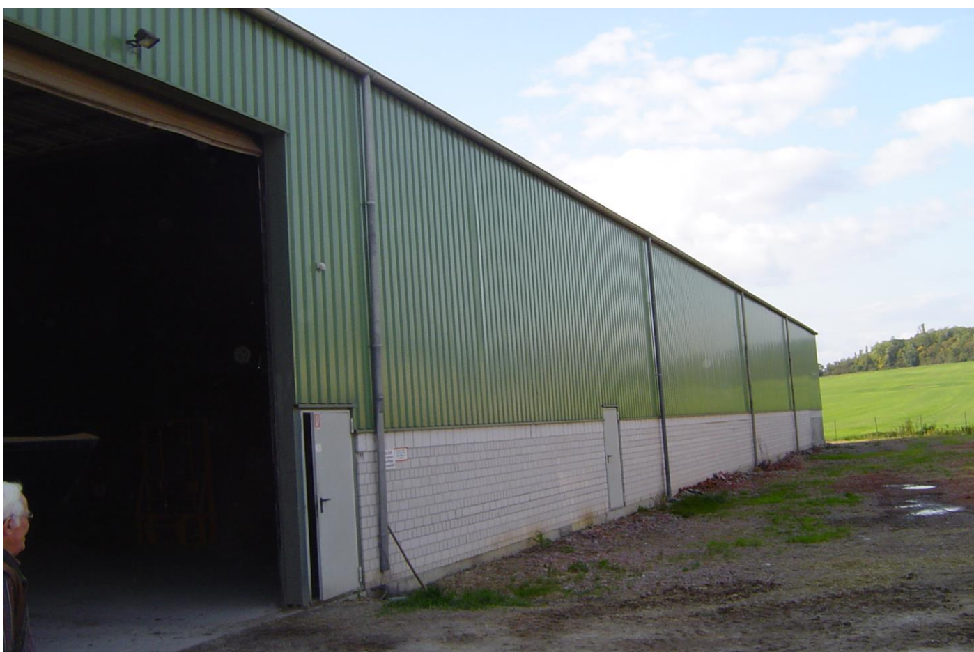
Een van Oltman Tonkens zijn opslagschuren. 20 meter bij 70 meter. Opslagcapaciteit van 1400 vierkante meter.
