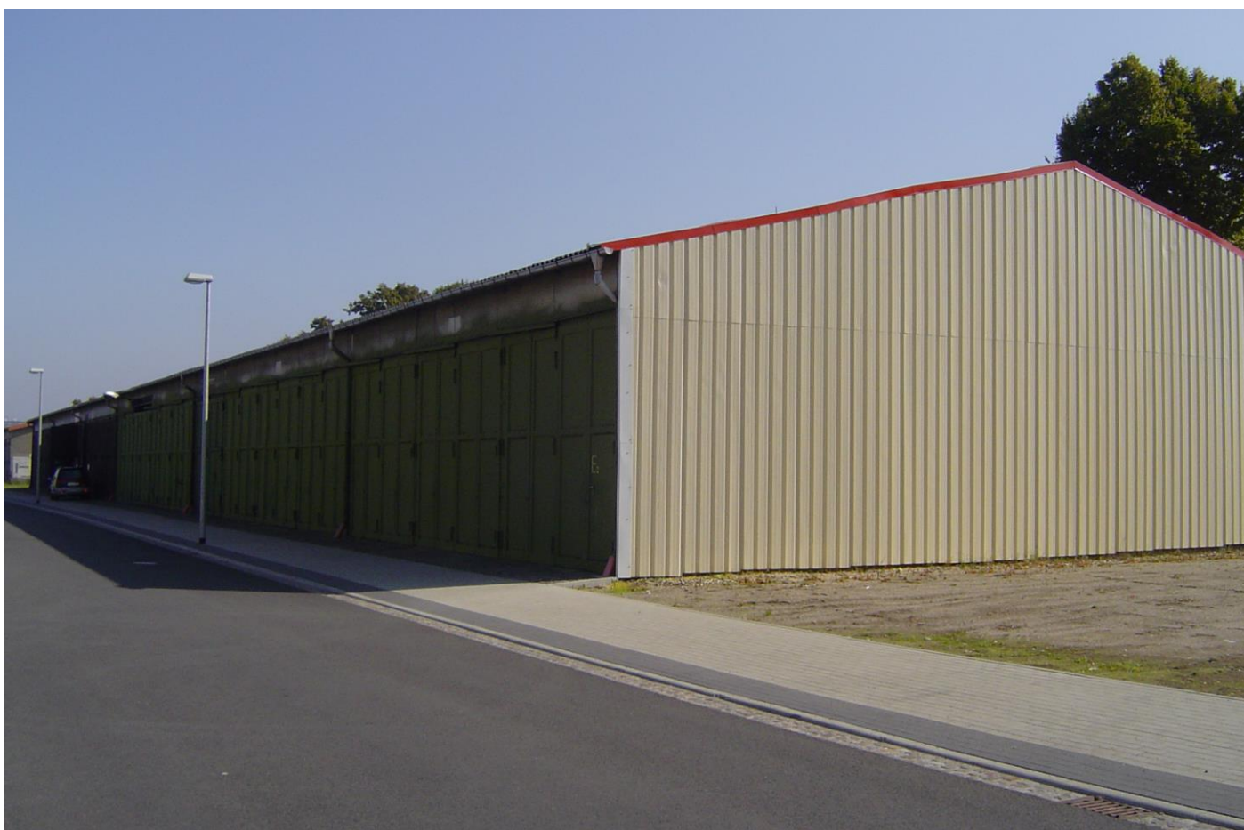
De oude Russische gebouwen in Torgau zijn veranderd in gigantische opslagloodsen die tot de laatste meter zijn verhuurd met een opslagcapaciteit van veertigduizend ton.
