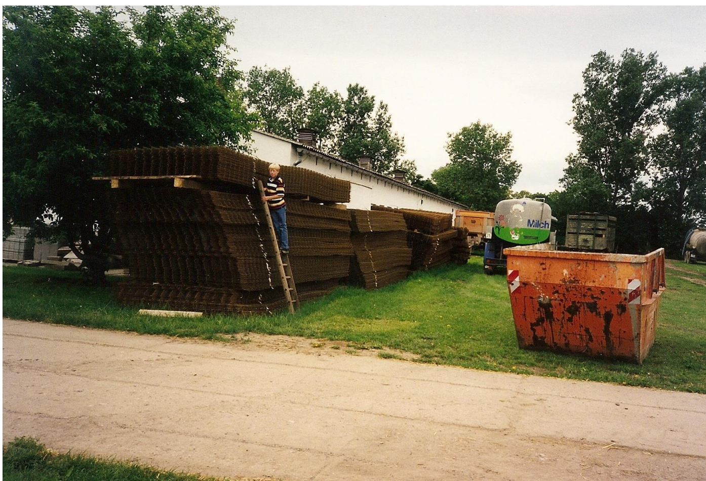
Tachtig ton betonijzer werd verwerkt door Poolse medewerkers op de bedrijven in Stemmern.
