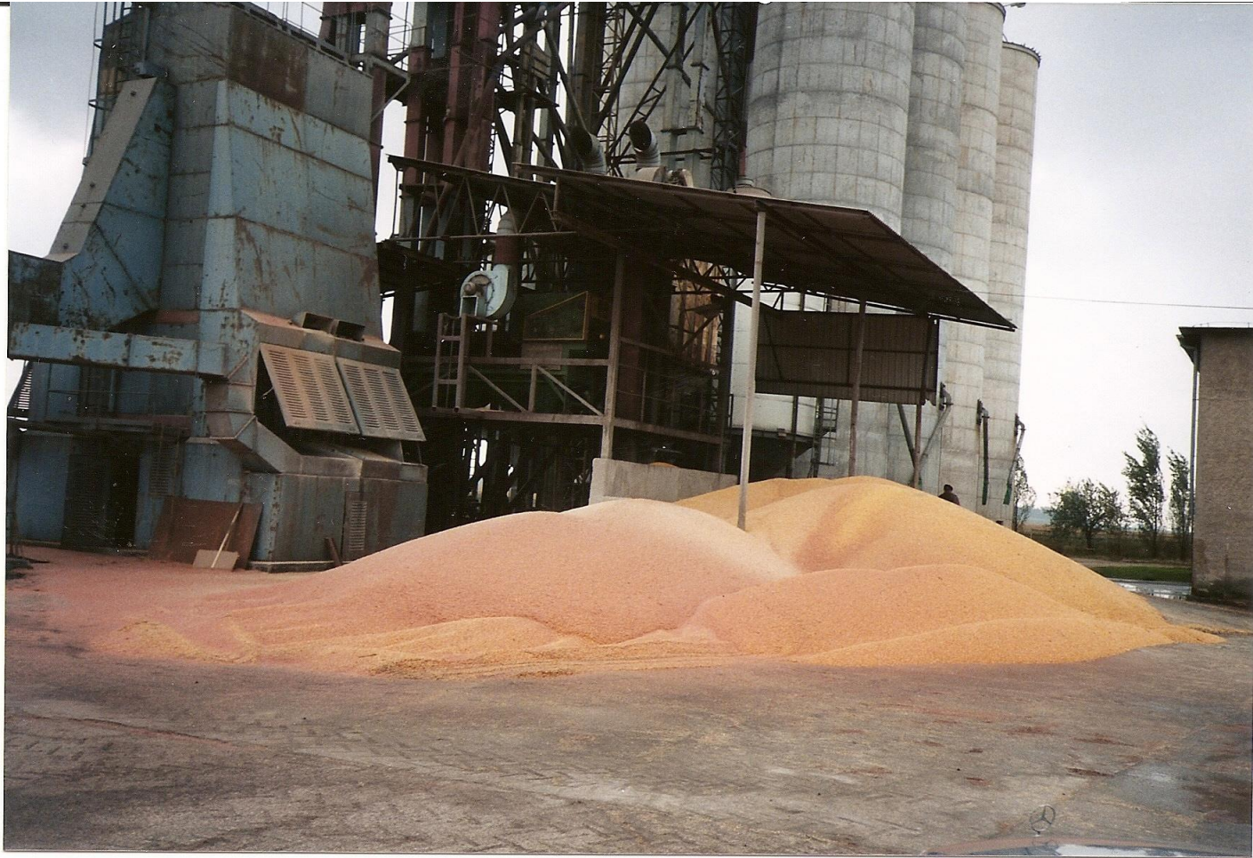
Maisdrogen Siecieborewice in Polen. Acht betonsilo's van 500 ton= 4000 ton opslagcapaciteit.
