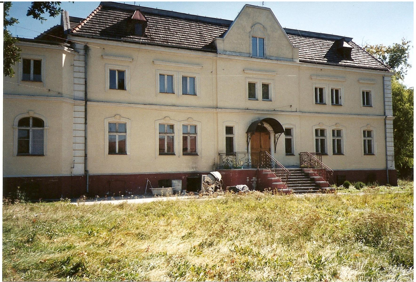
Achterzijde van Kasteel te Siecieborowice tijdens de eerste verbouwingen en renovatie.
