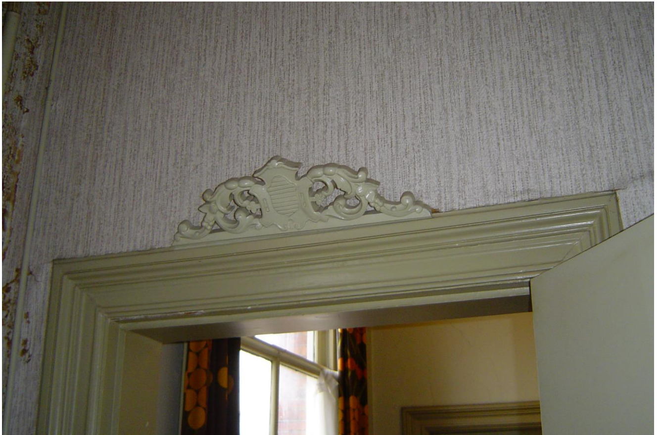
Rechtzaal; houten omlijstingen van de deuren waarboven decoraties.
