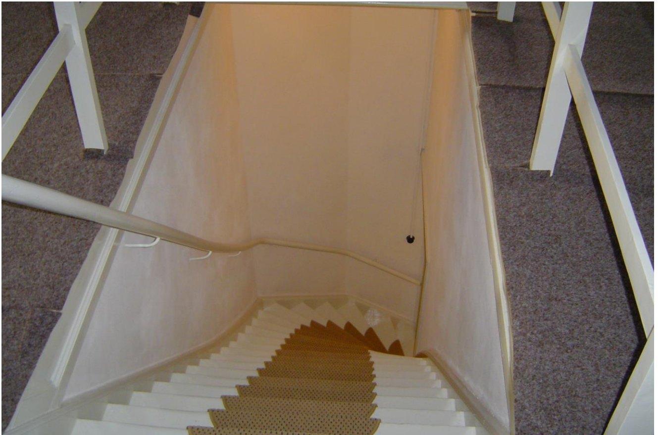
De trap vanaf de bovenste zolder. Het trappgat gestukadoord en afgesausd en de trap geschilderd en met halve maantjes belegd.
