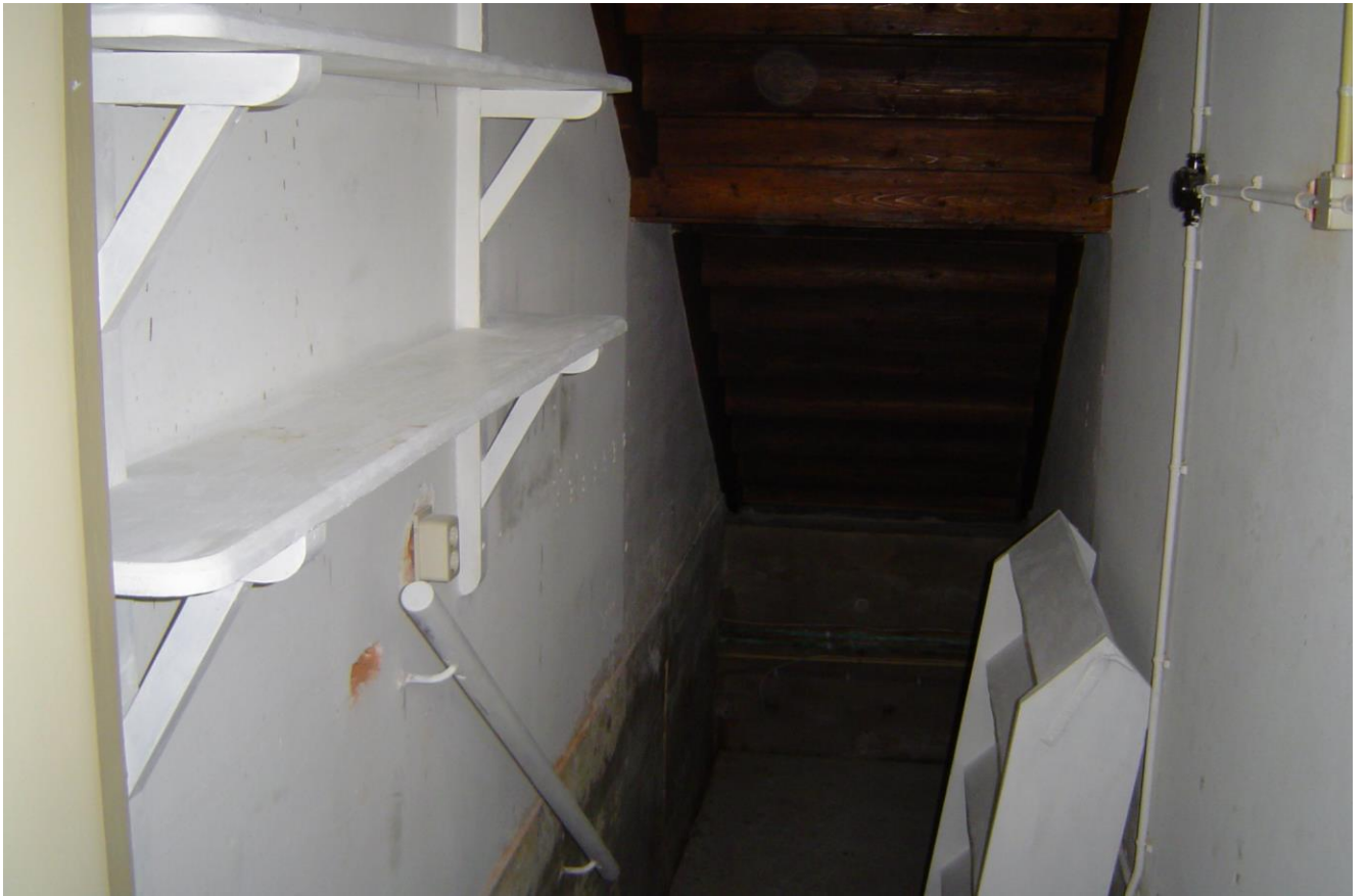
De kelder voor- en na het grondverven.
