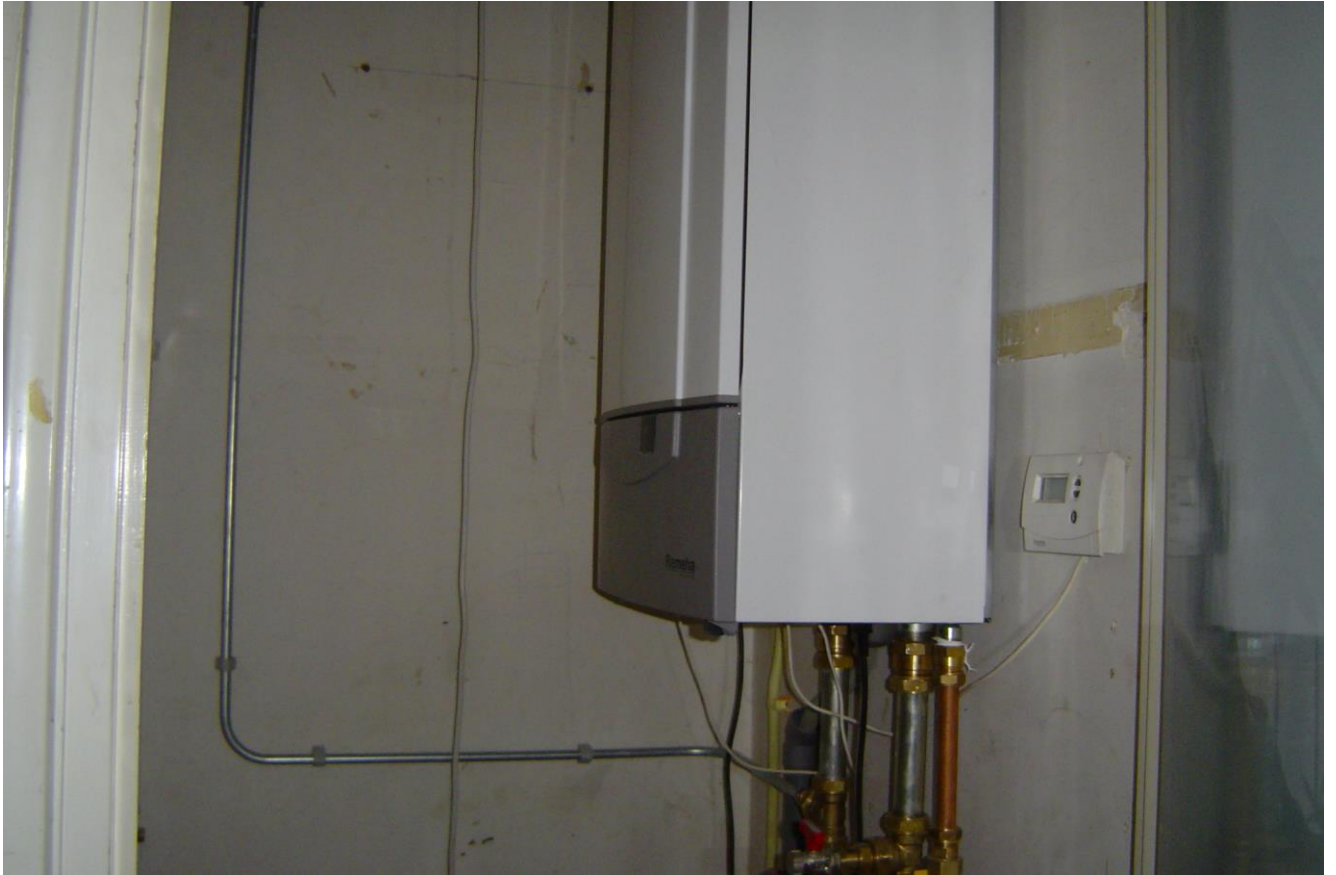
De nieuwe CV ketel in bedrijf.
