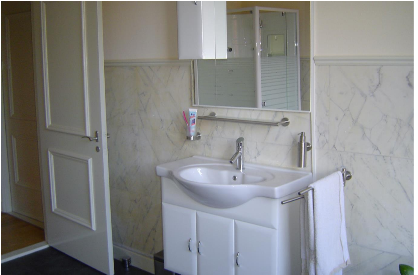
Bij de renovatie kwam onder het behang een muur tevoorschijn met imitatie – marmar.
