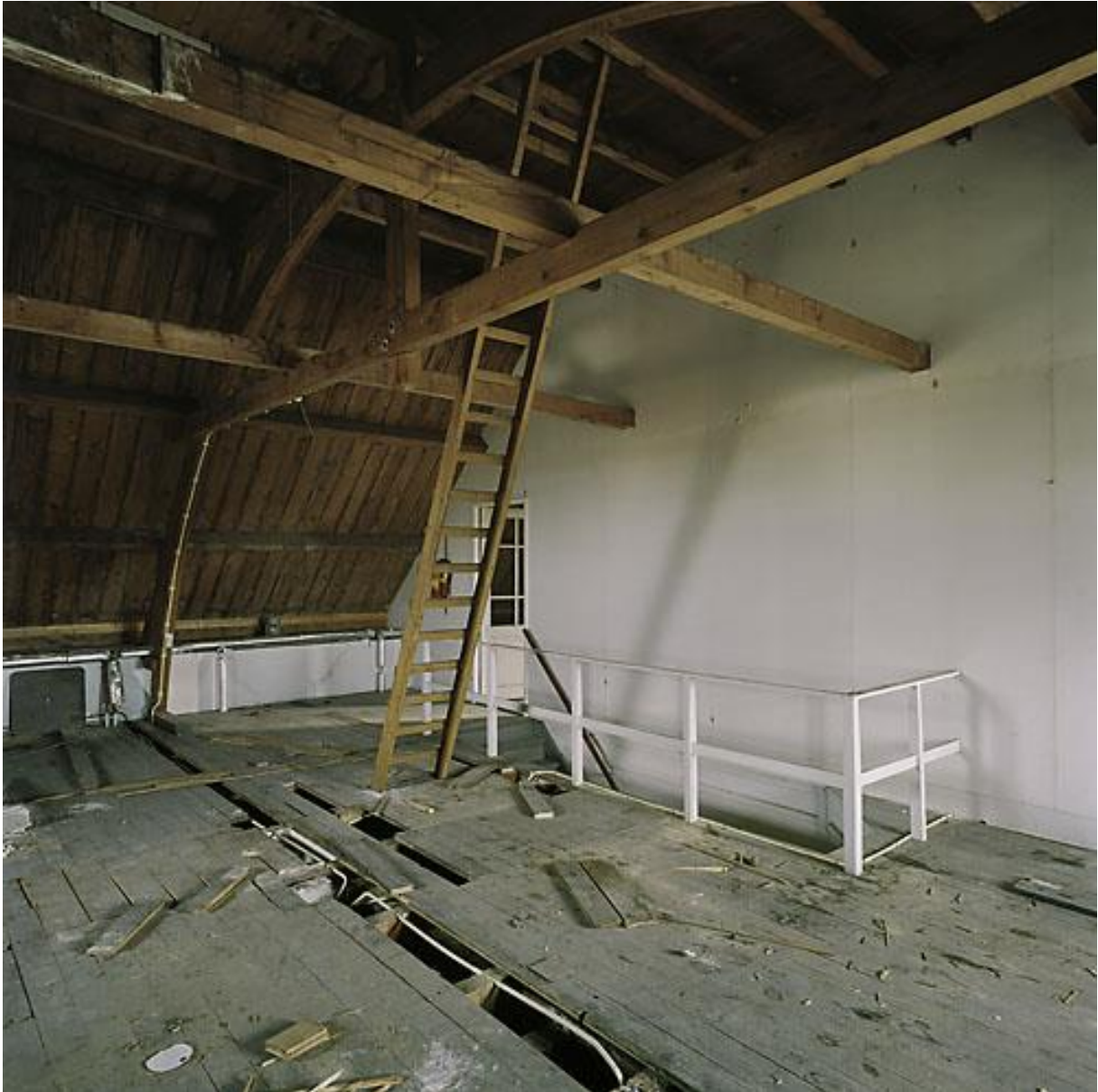
De bovenzolder wordt gerenoveerd. Elektriciteitsleidingen vernieuwd en uit het 'zicht' gemonteerd.
