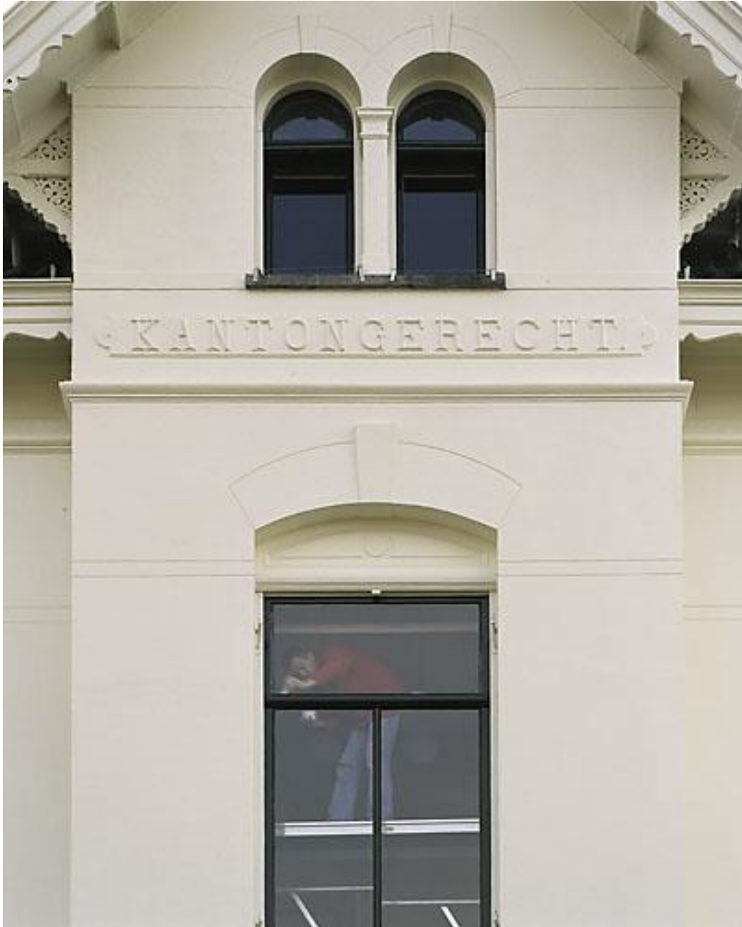
Smettelos zijn de muren na het schilderen
