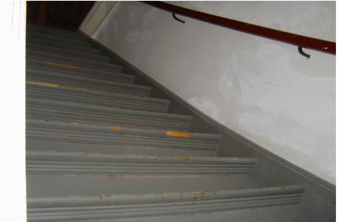
De muur van het trappgat opnieuw gepleisterd en daarna wordt het opnieuw afgesausd.
