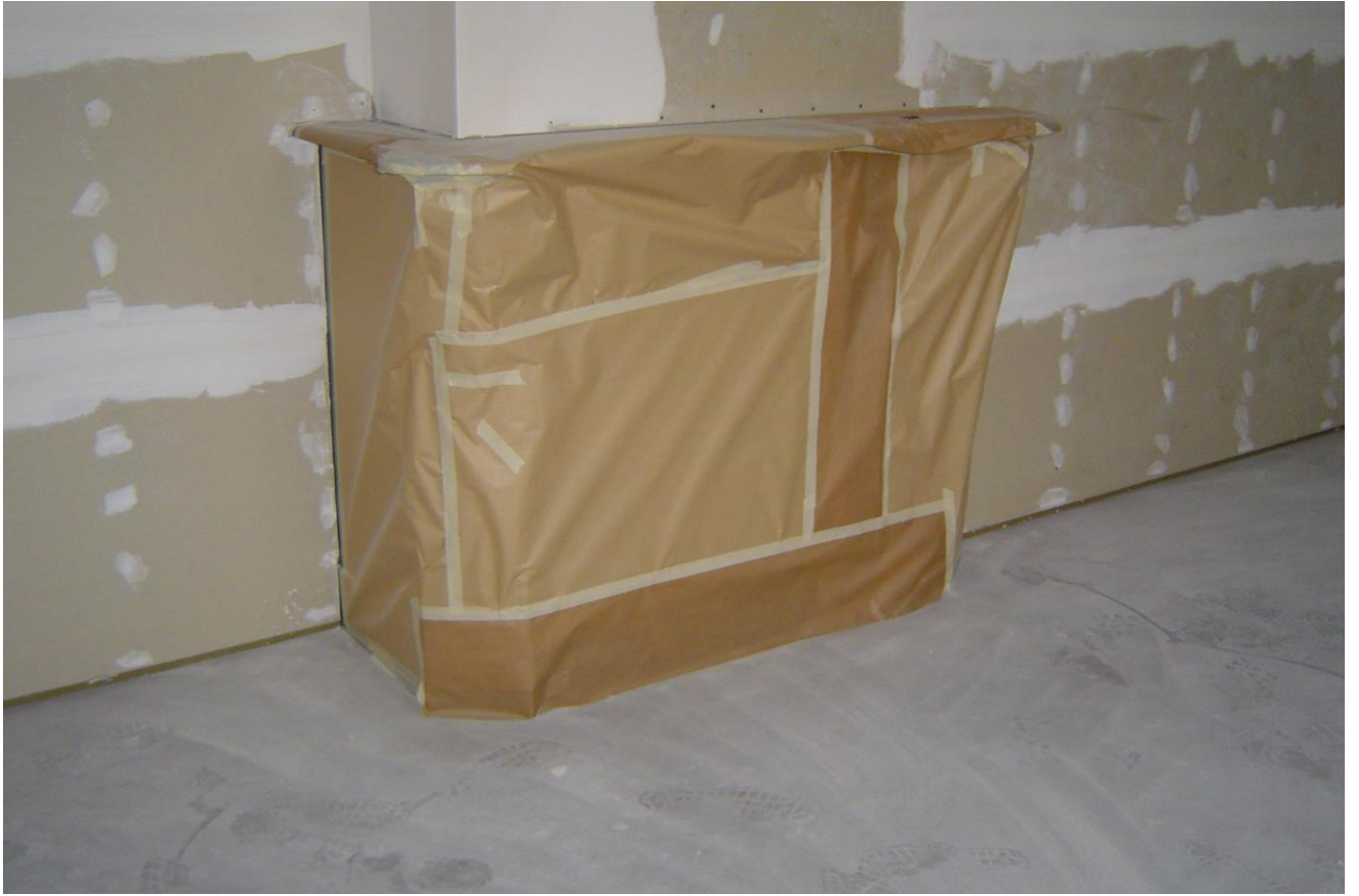
Ook de schoorsteenmantel is afgeplakt
