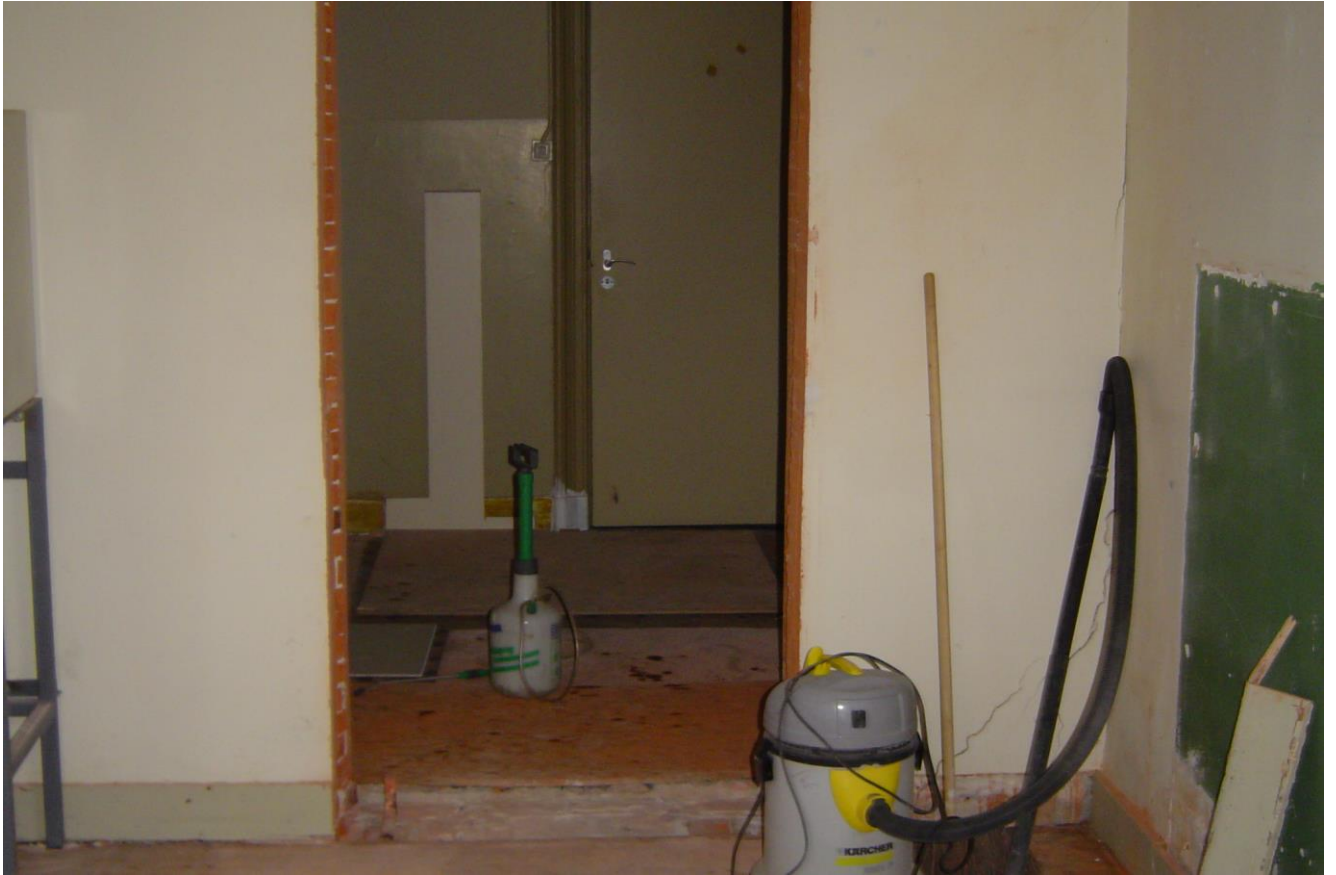
Muur is uitgebroken voor een deurdoorgang. Januari 2007.
