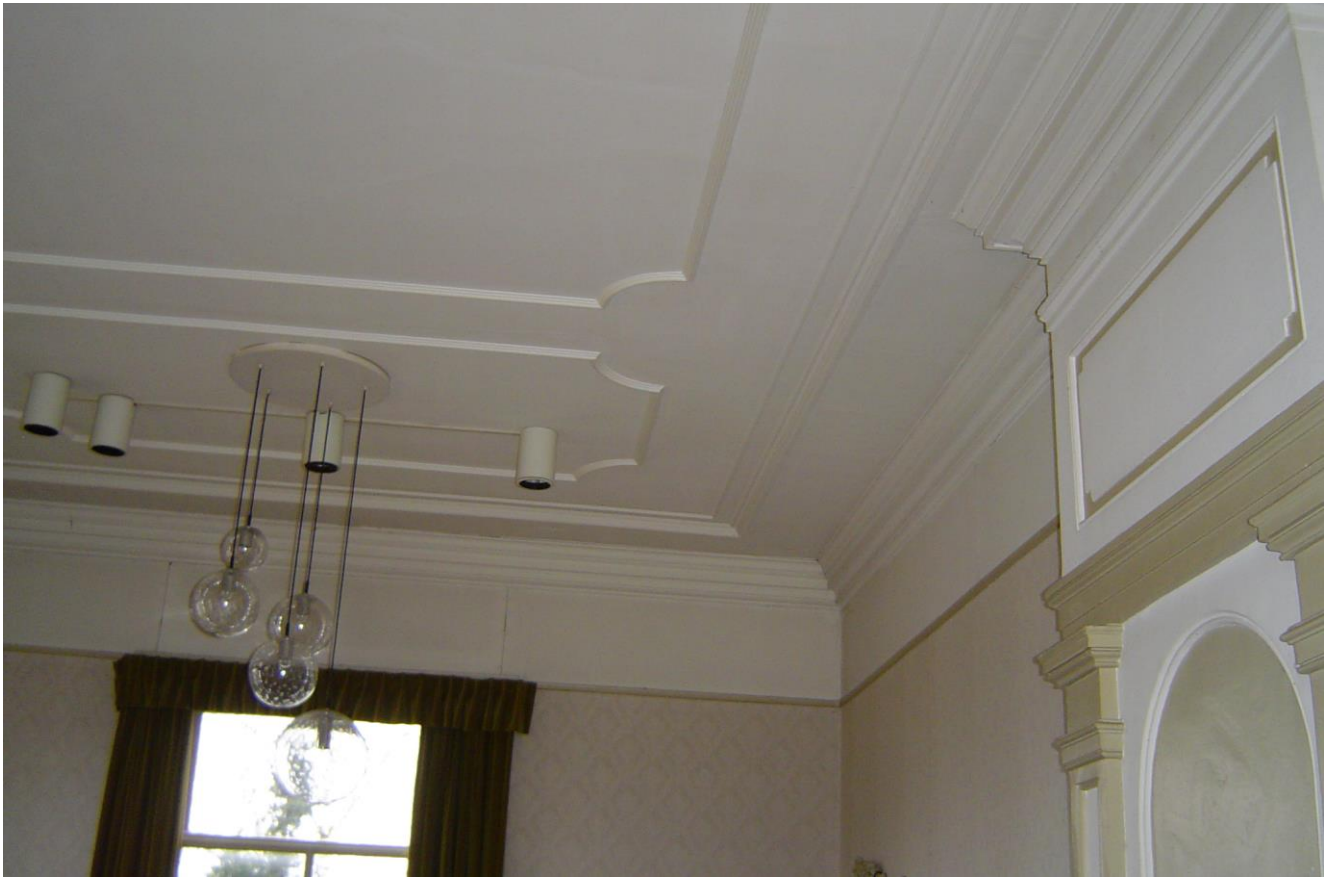
Lampen en plafond in rechtzaal.
