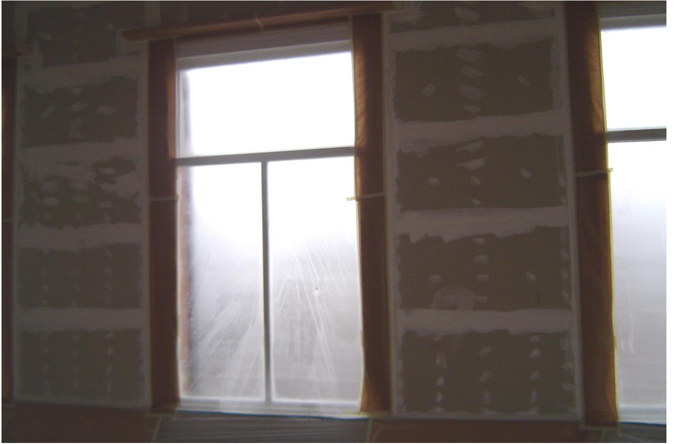
Plastic voor de ramen en afgeplakte kozijnen.
