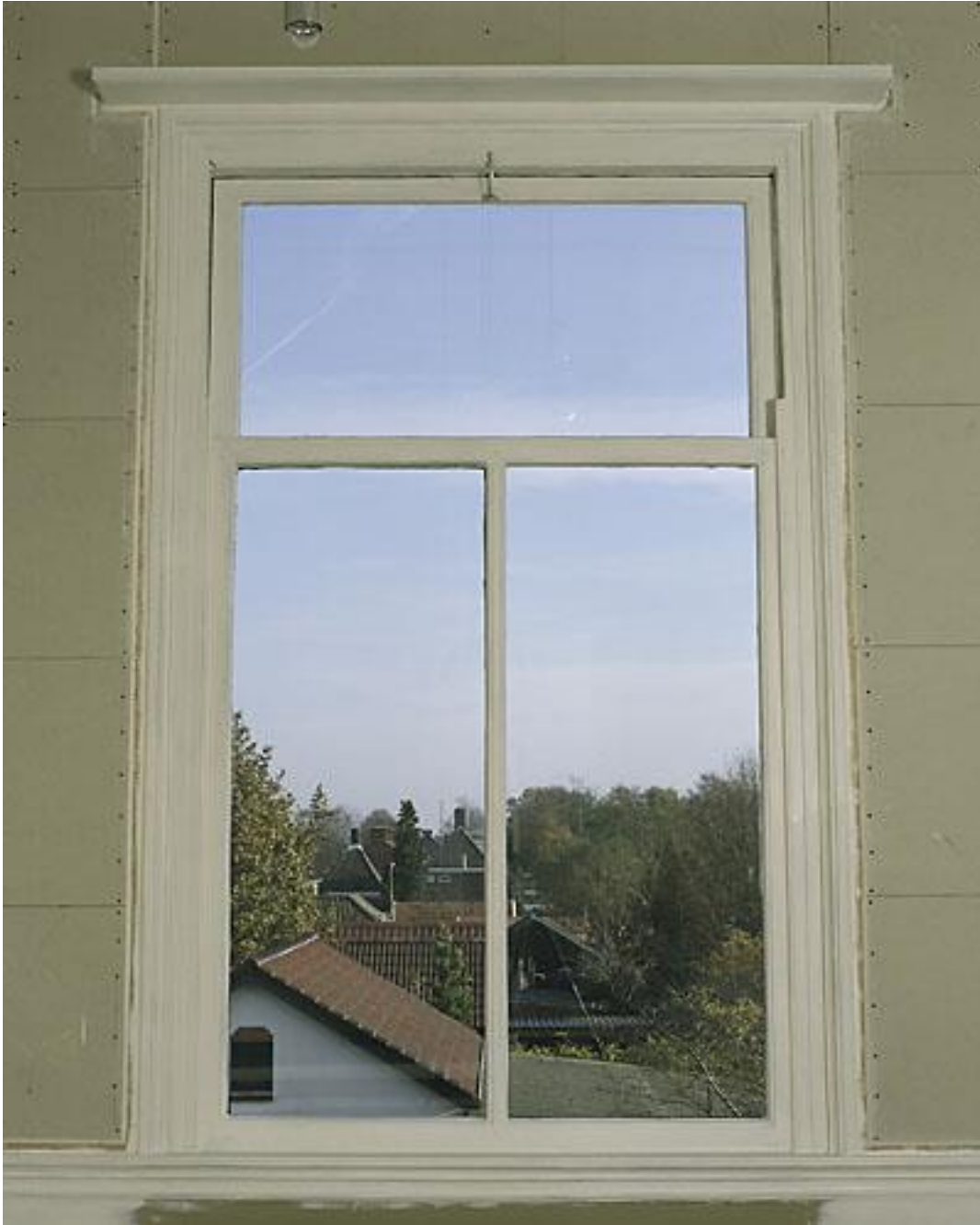
Kozijn in de wachtkamer. Nieuwe gipswanden zijn gemonteerd.
