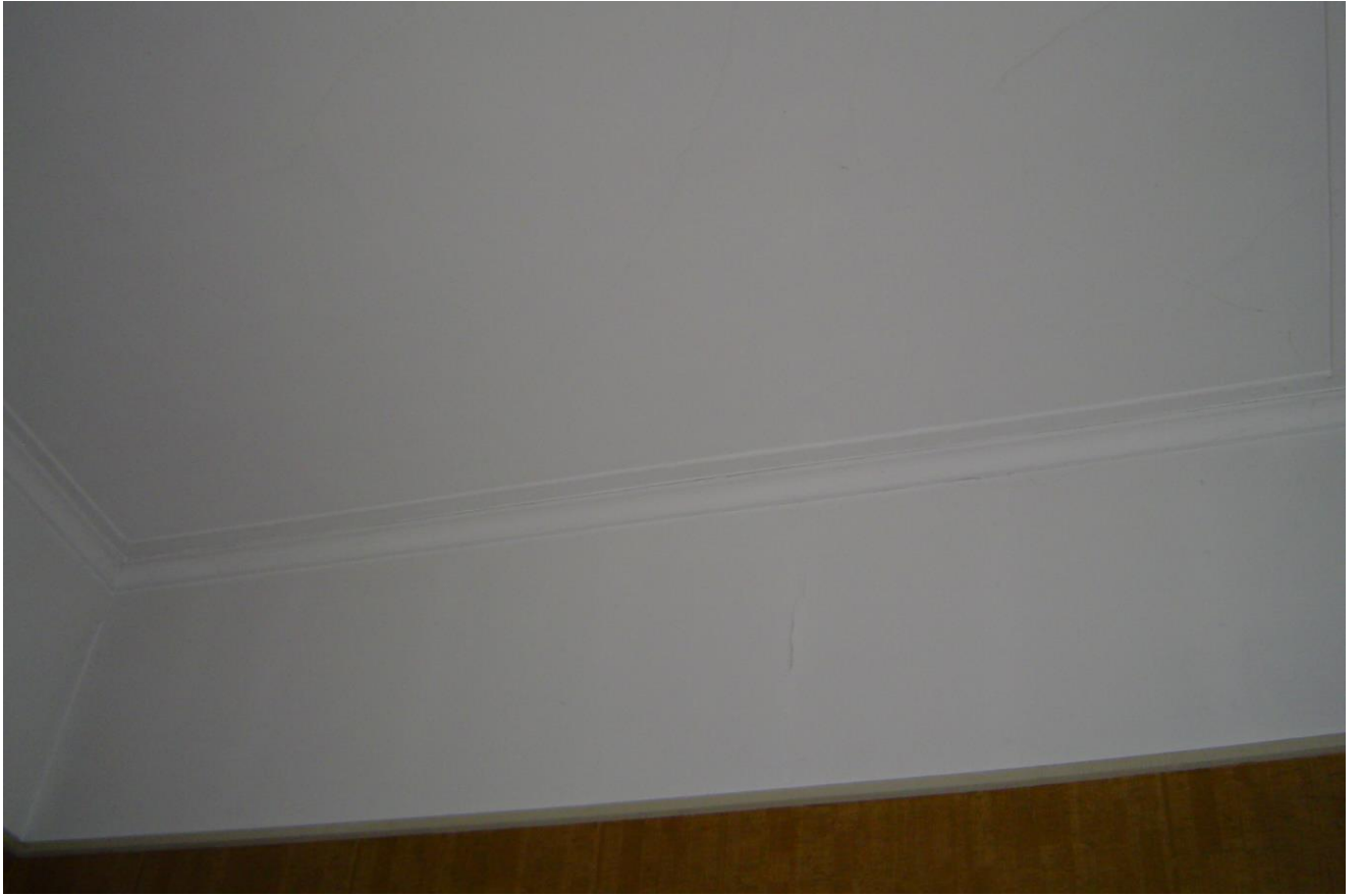
Bovenverdiepingkamer; plafond met zijwanden
