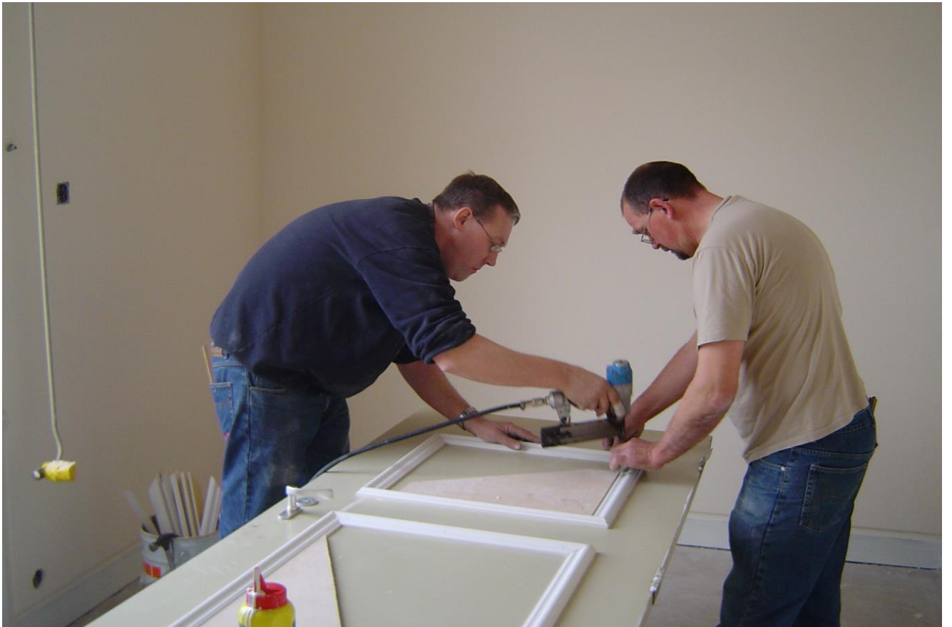
Profiellijsten worden gelijmd en daarna geniet.
