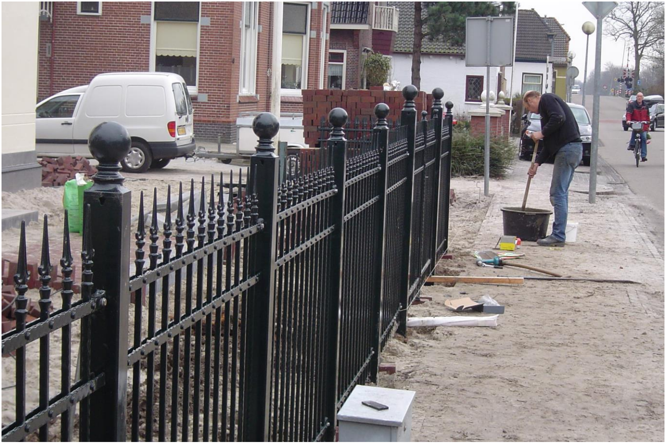
De hekwerkfundatie met beton afgieten.
