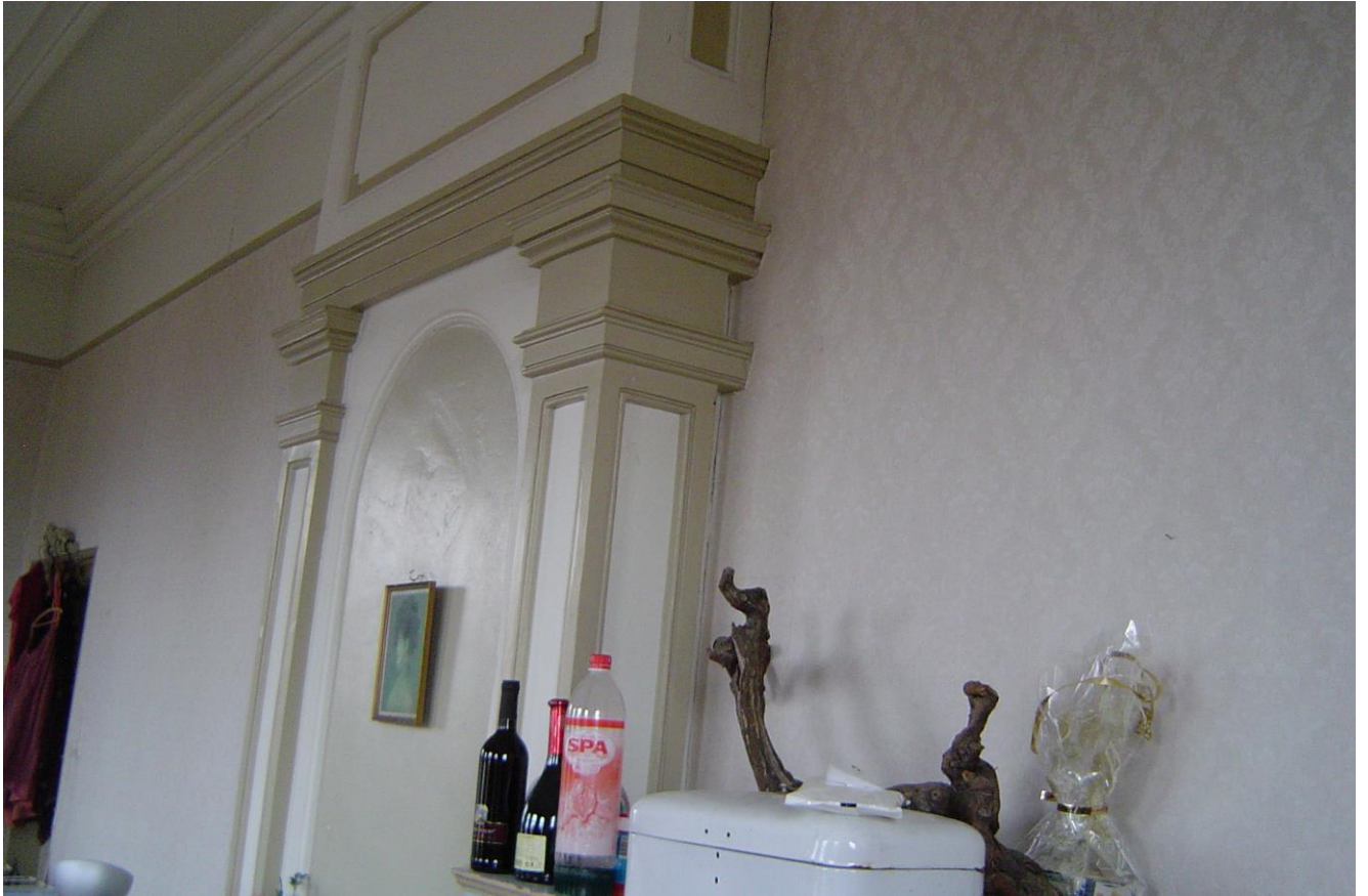
Schouw in rechtzaal.
