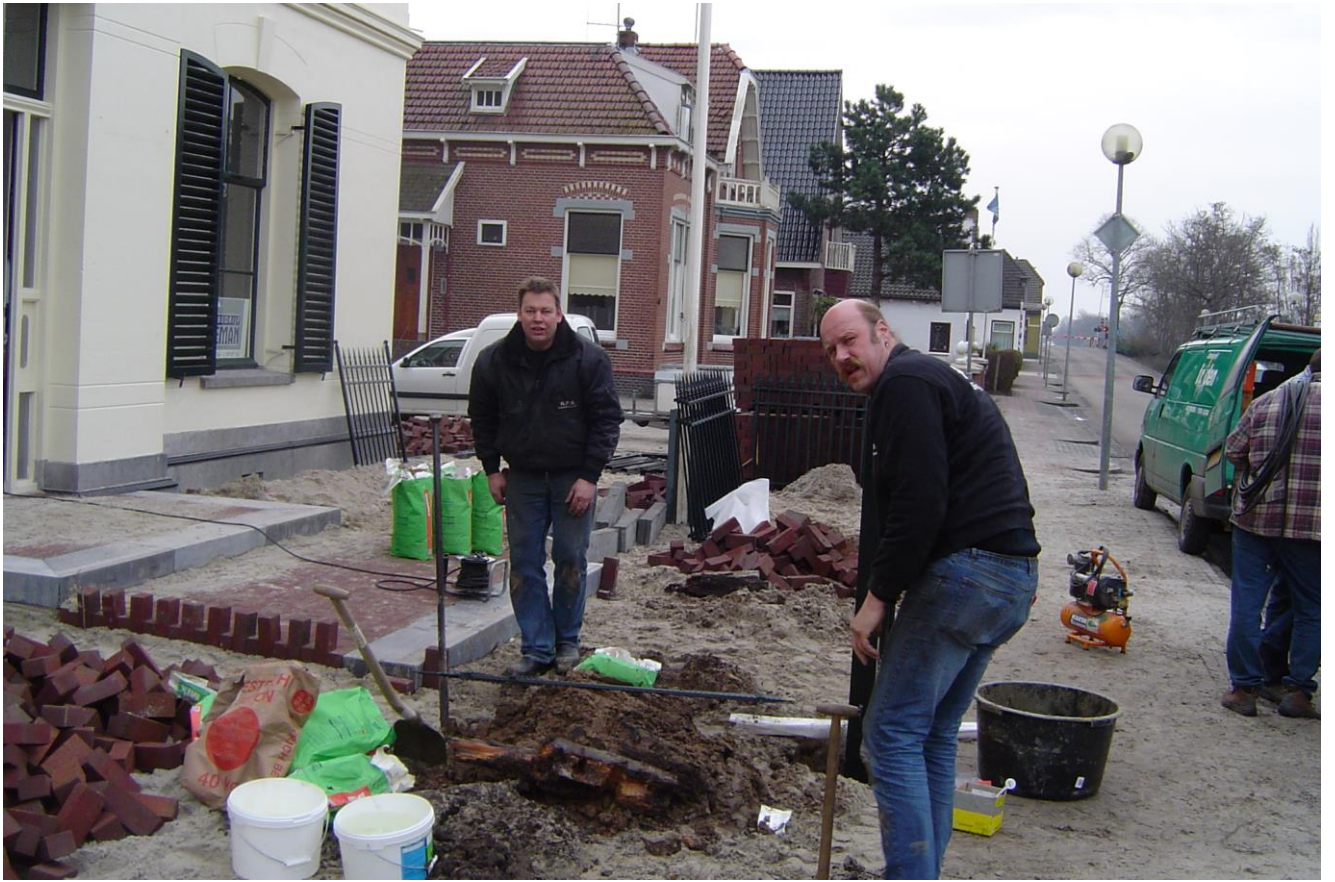
Herman Wallage met zijn medewerker Henk plaatsen het hekwerk.
