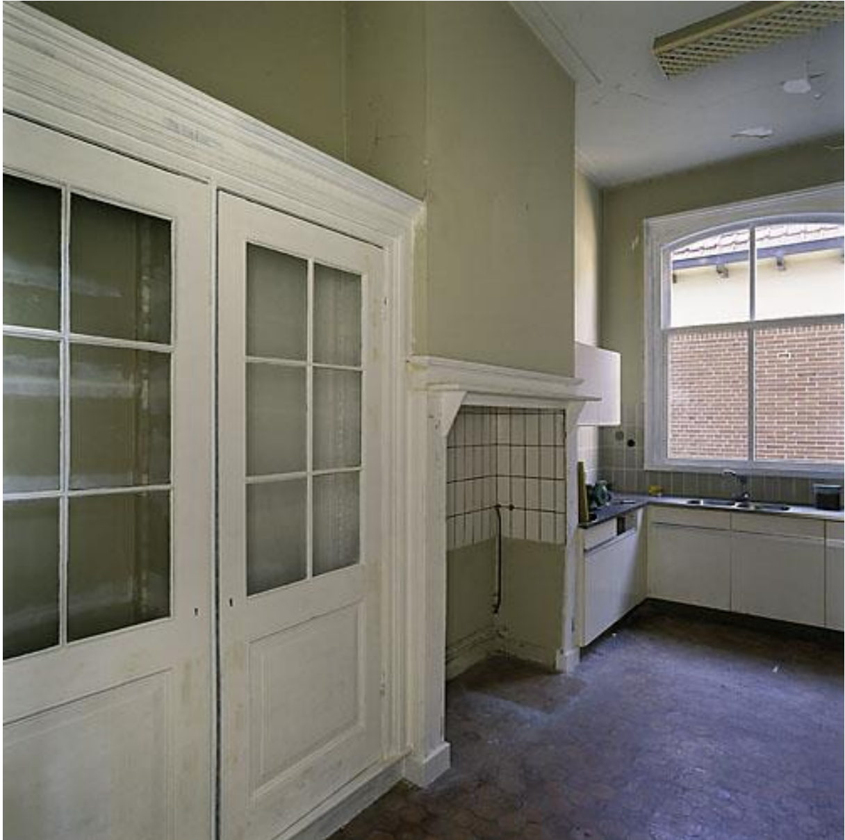
Keuken. De monumentale servieskast is gerenoveerd en in de grondverf gezet
