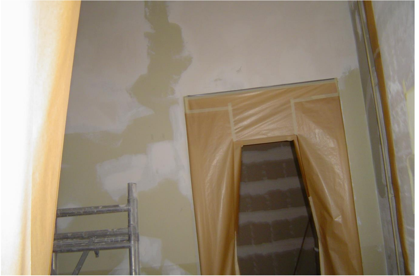
Alle kozijnen afgeplakt voor het spacwerk.
