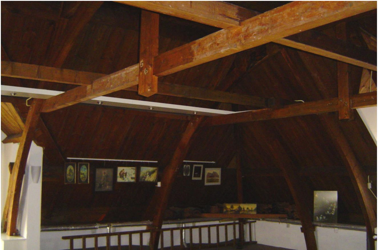
De zolder geschoond. De kap behandeld met antihoutworm en daarna behandeld met een impregneermiddel op lijnolie basis.
