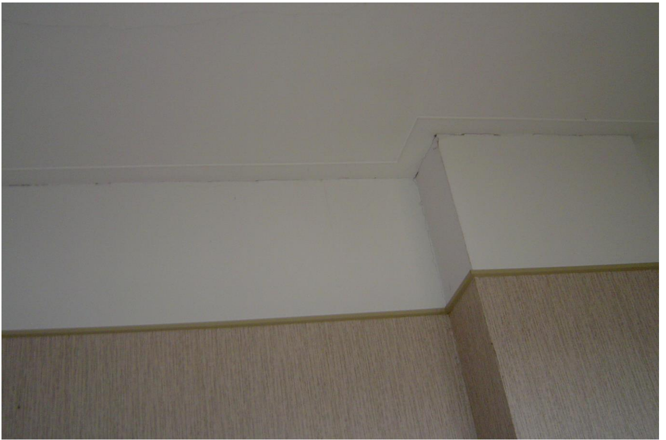
Kamer kantonrechter; wand met plafond.
