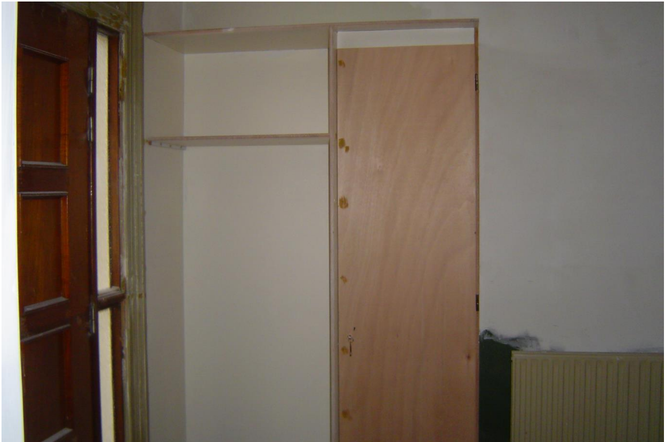
Meterkast in de hal is afgetimmerd met ernaast een garderobekast.
