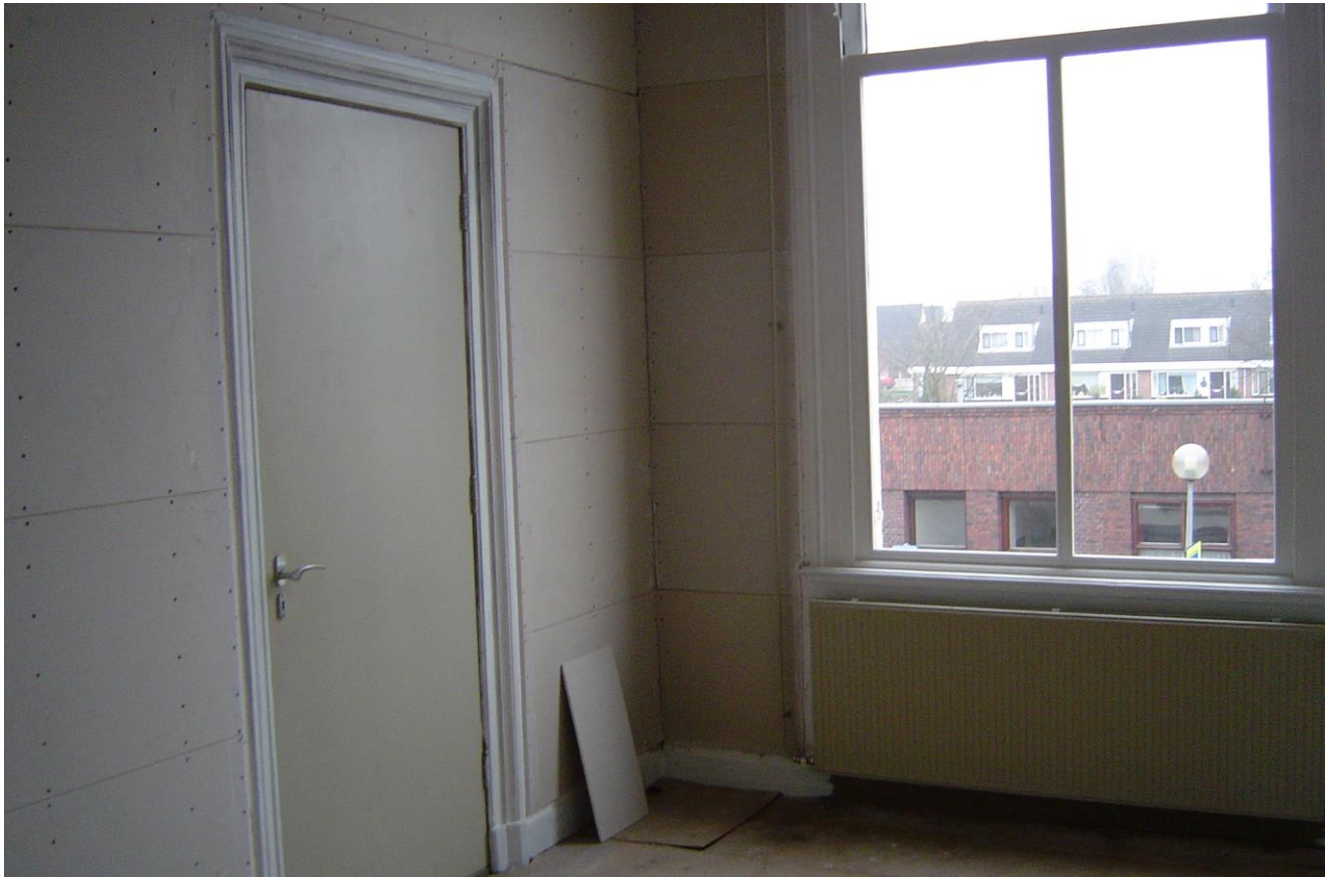
Tussenkamer bekleed met gipswanden.
