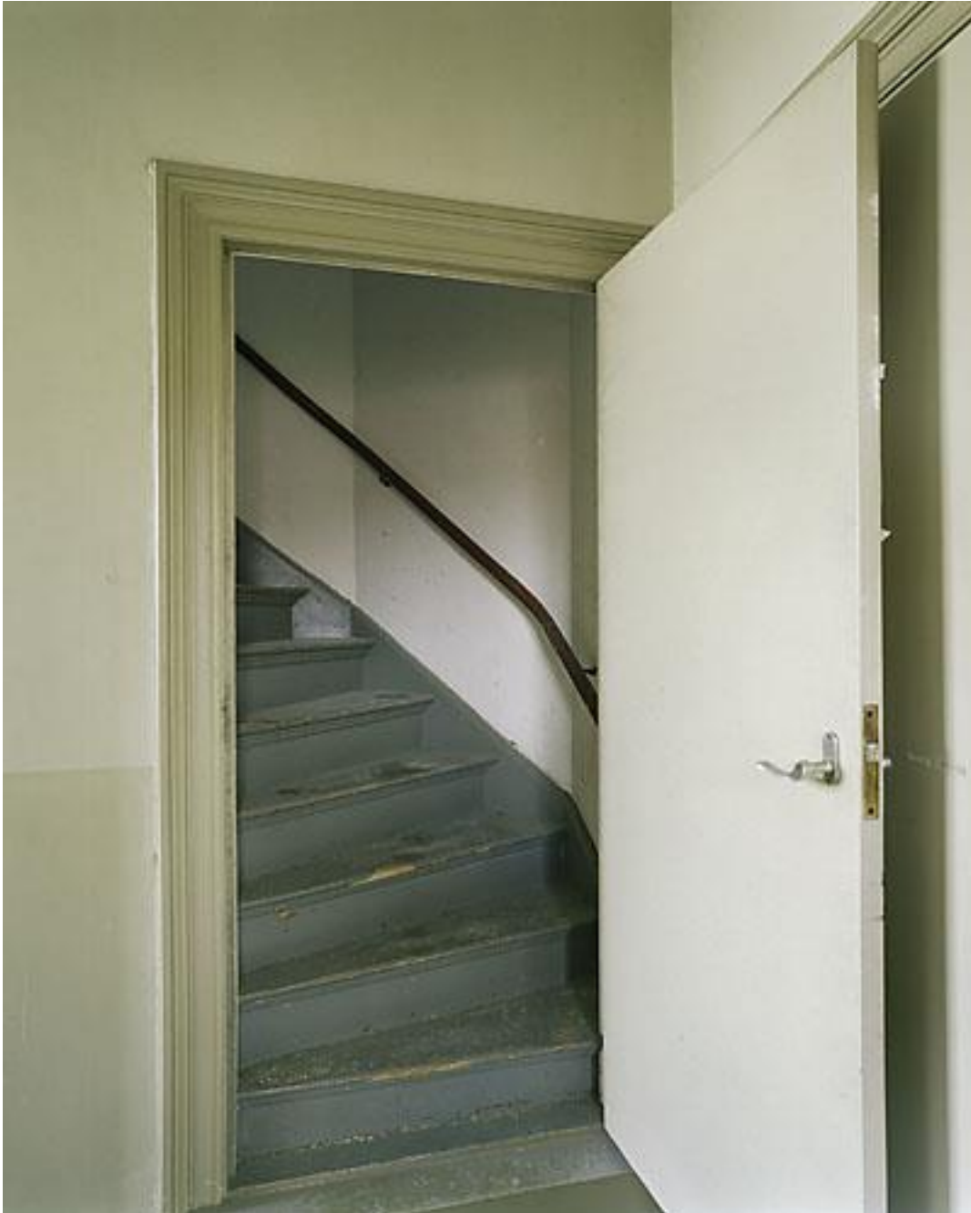
Trapopgang naar de bovenste verdieping
