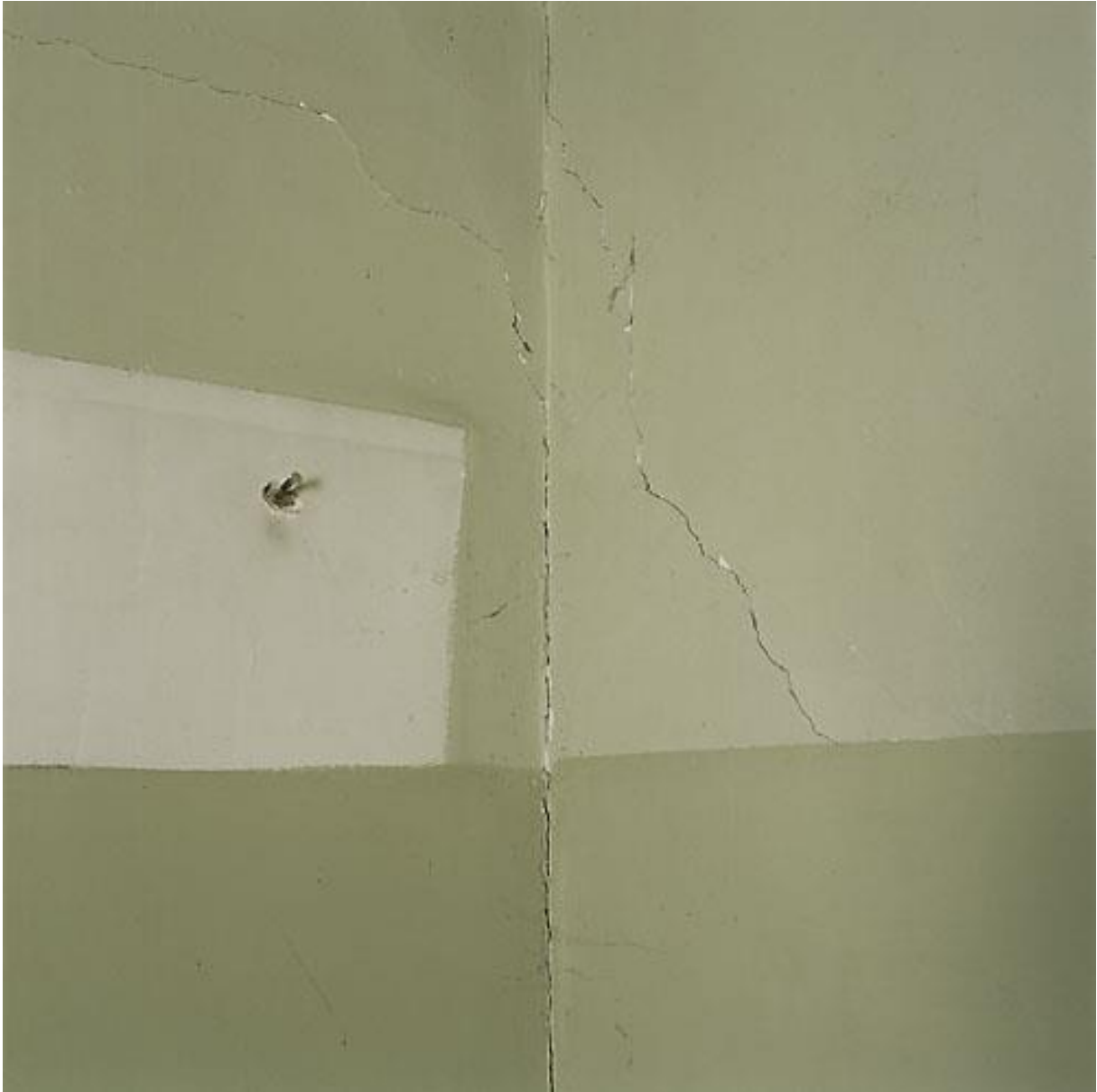
Vele scheuren in de muren die we uithakken en opnieuw stukadoren.
