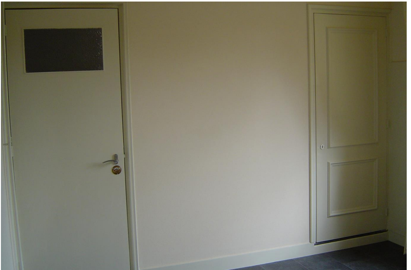
Douchedeur en CV-ruimtede deur.
