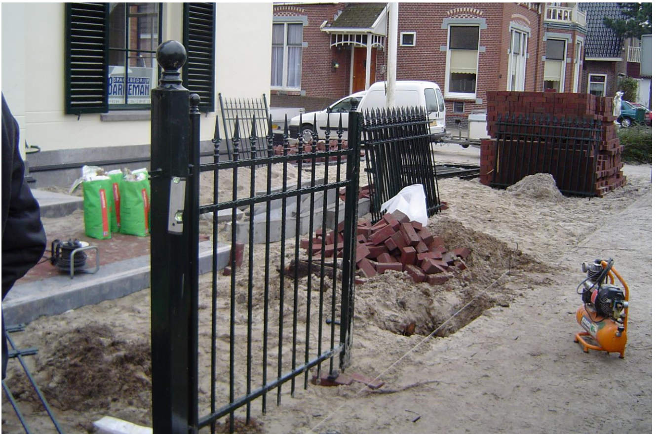
Hekwerk wordt geplaatst.
