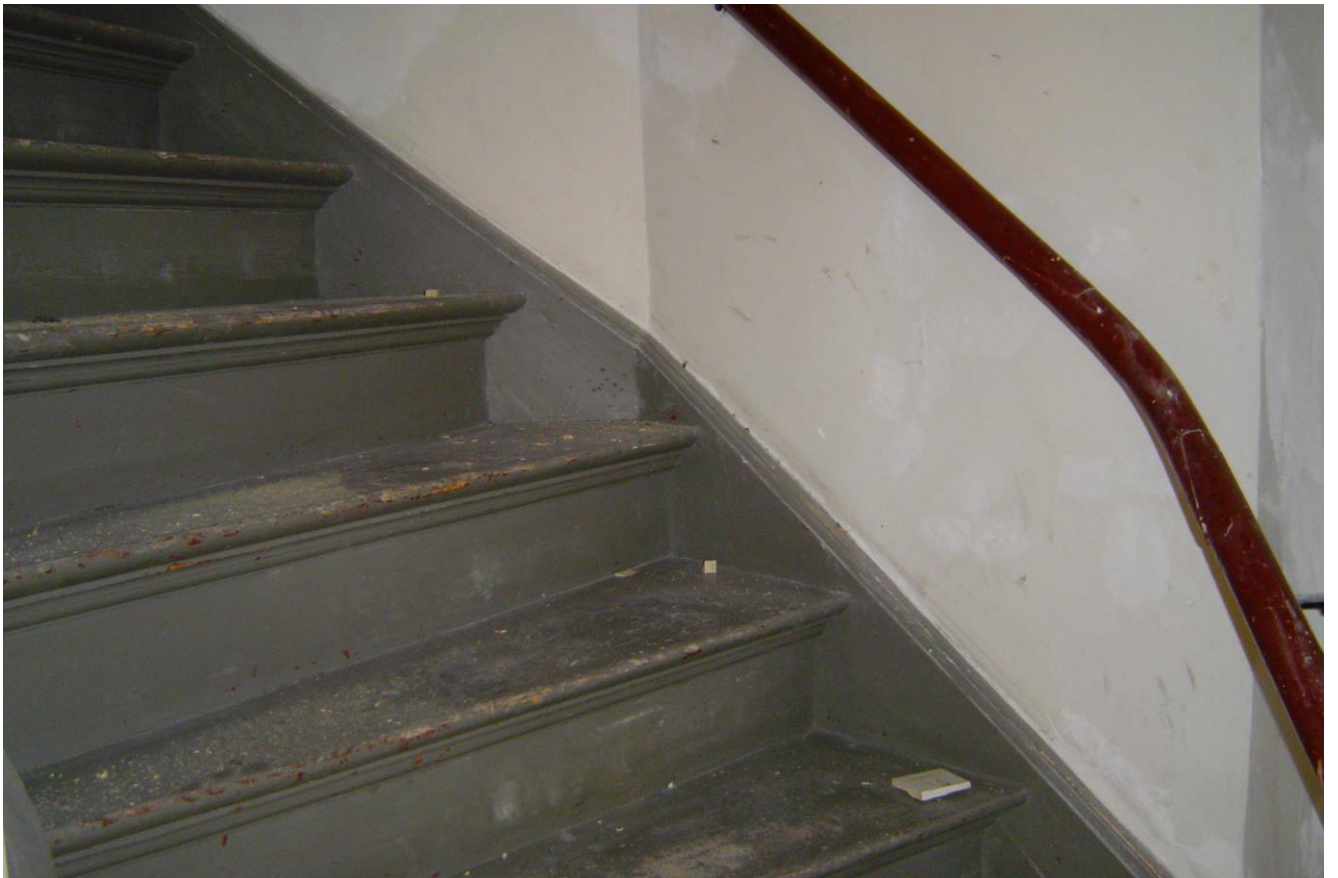
Trap naar de bovenste etage. De renovatie is hier nu in volle gang.
