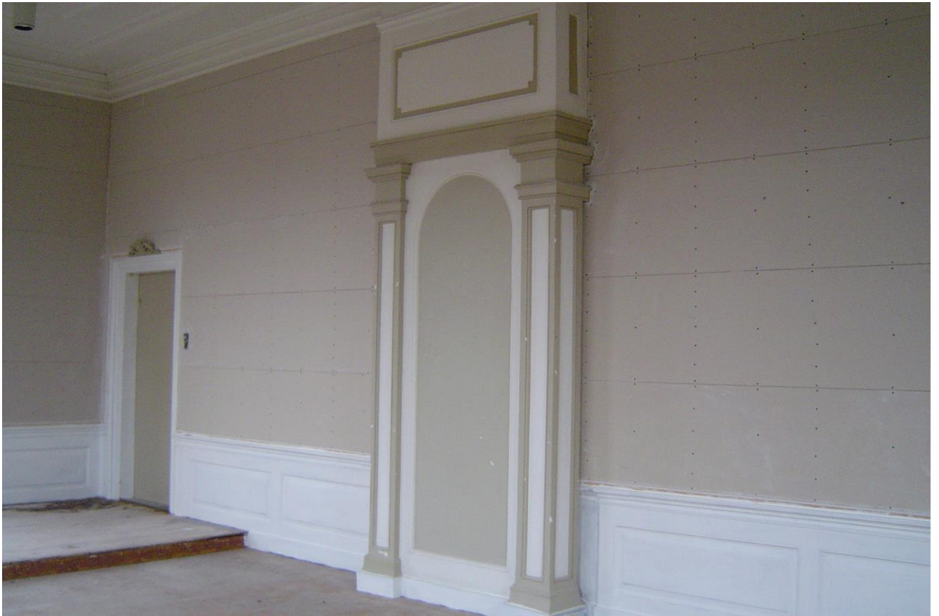
Voorkamer met schouw en pilasters.
