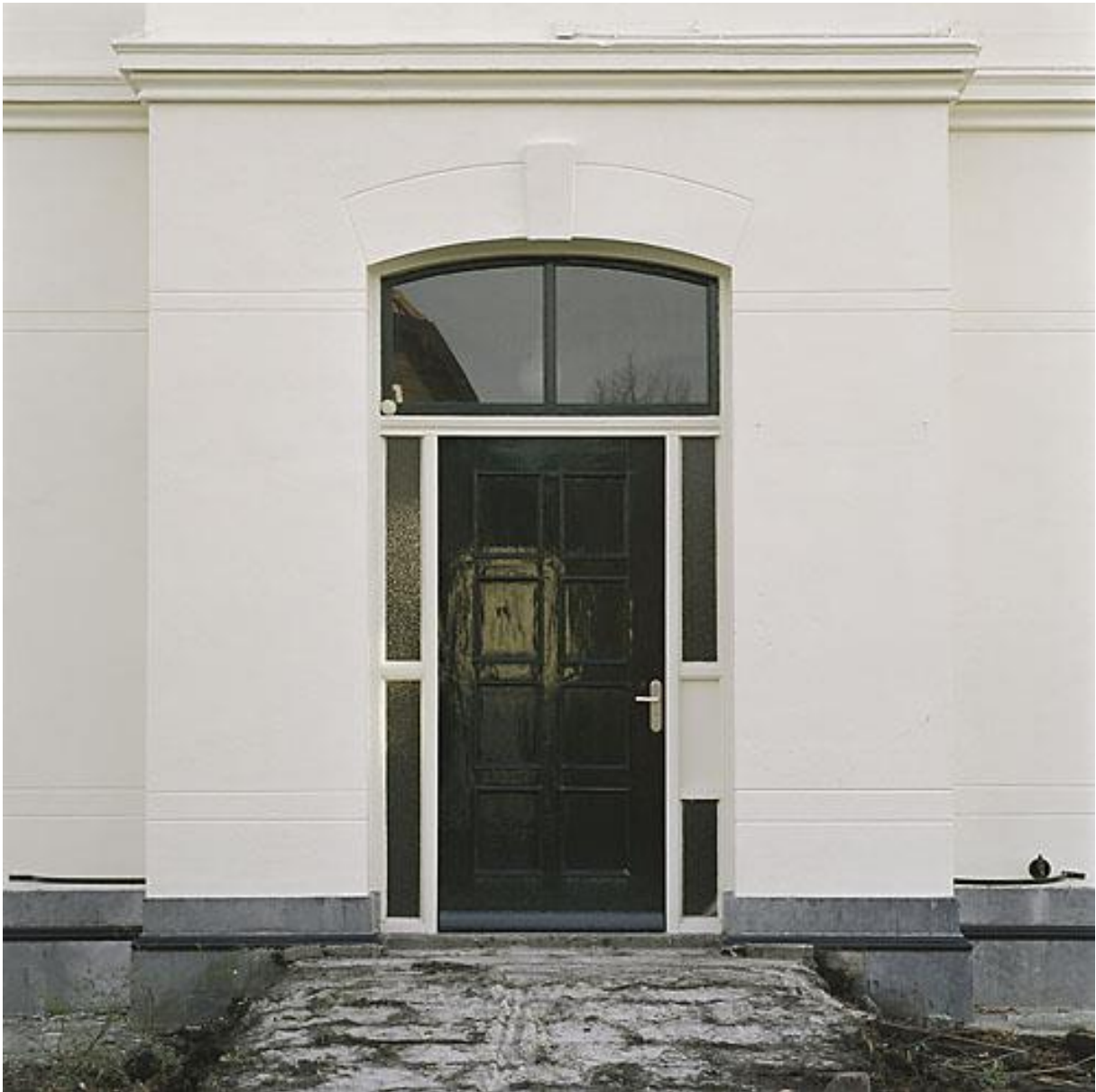
Renovatie rondom is nog in volle gang.
