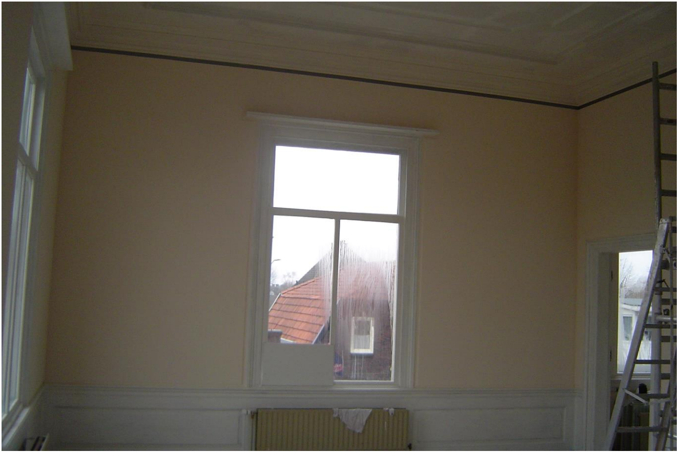
De voormalige rechtzaal is gespaakt .
