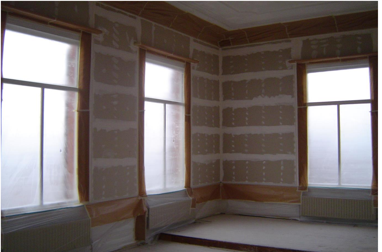
Ook de oude rechtzaal is geheel afgeplakt en staat gereed voor het eerste spacwerkt.
