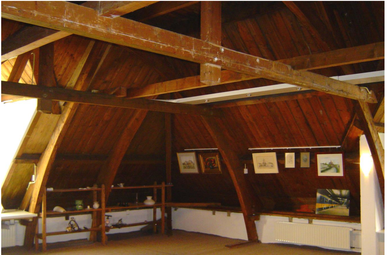
De gehele kap is eerst stofvrij gemaakt, daarna met terpentijn nageschoond en toen geheel ingesmeerd met een impregneermiddel op lijnolie basis.
