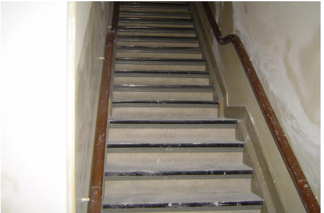
Trapgat naar 1 e verdieping is bijgepleisterd en gestukadoord.
