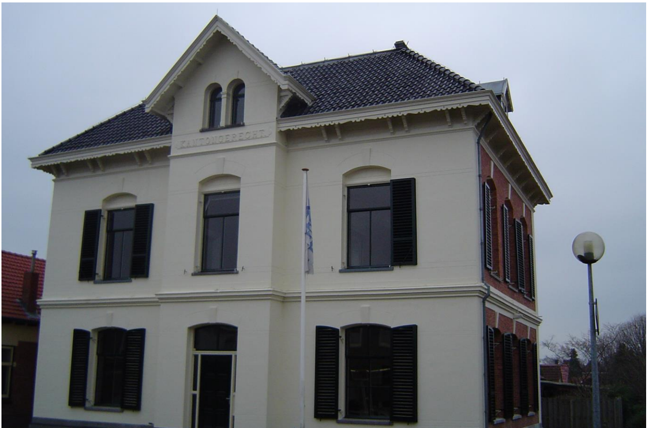
22-06-2006 De steigers zijn weg, de blinden gedeeltelijk opgehangen.
