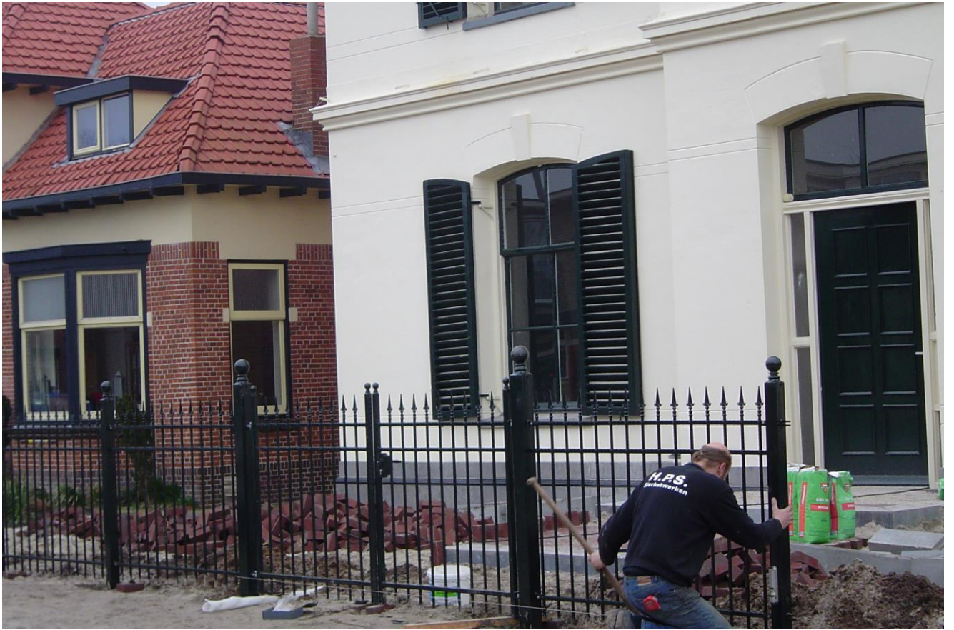
Gaten graven en hekwerk waterpas afstellen.
