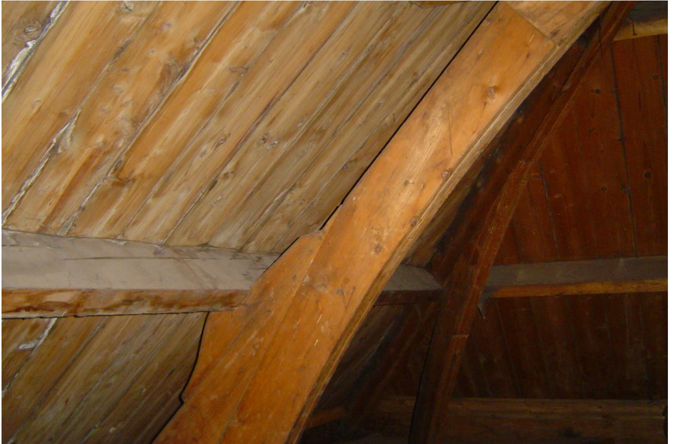
Dakbeschot en kapsanten.
