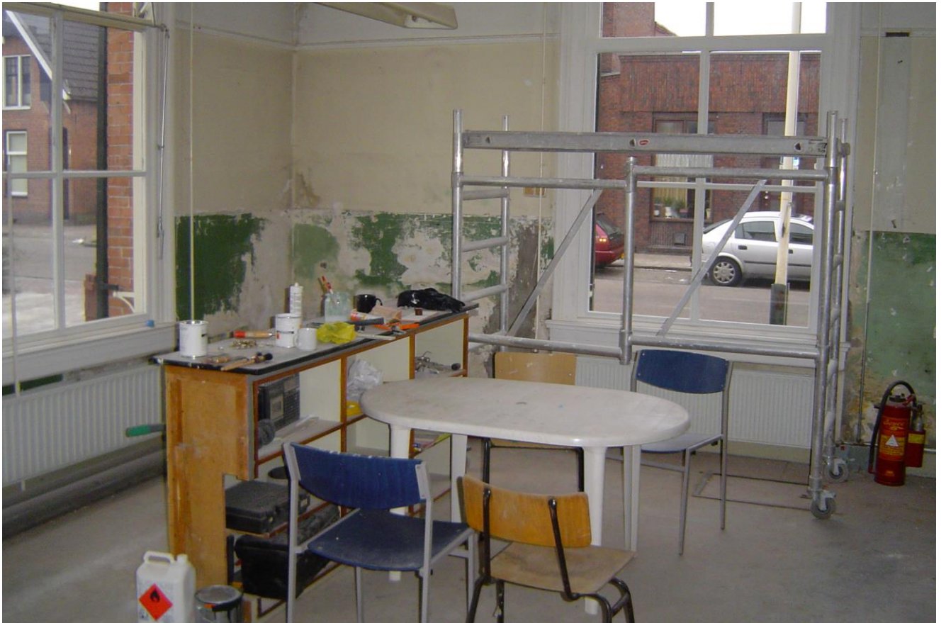
Steigers staan opgesteld voor schilderwerk aan de kozijnen.
