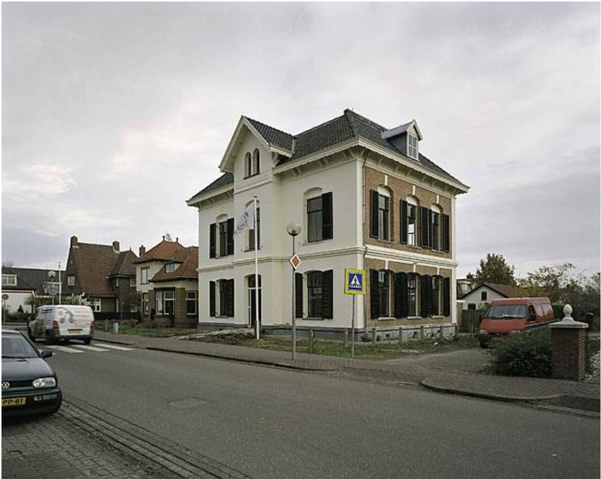
Het kantongerechtsgebouw is nog in restauratie. Enkele blinden worden nog gerenoveerd. Het hek is nog niet geplaatst.
