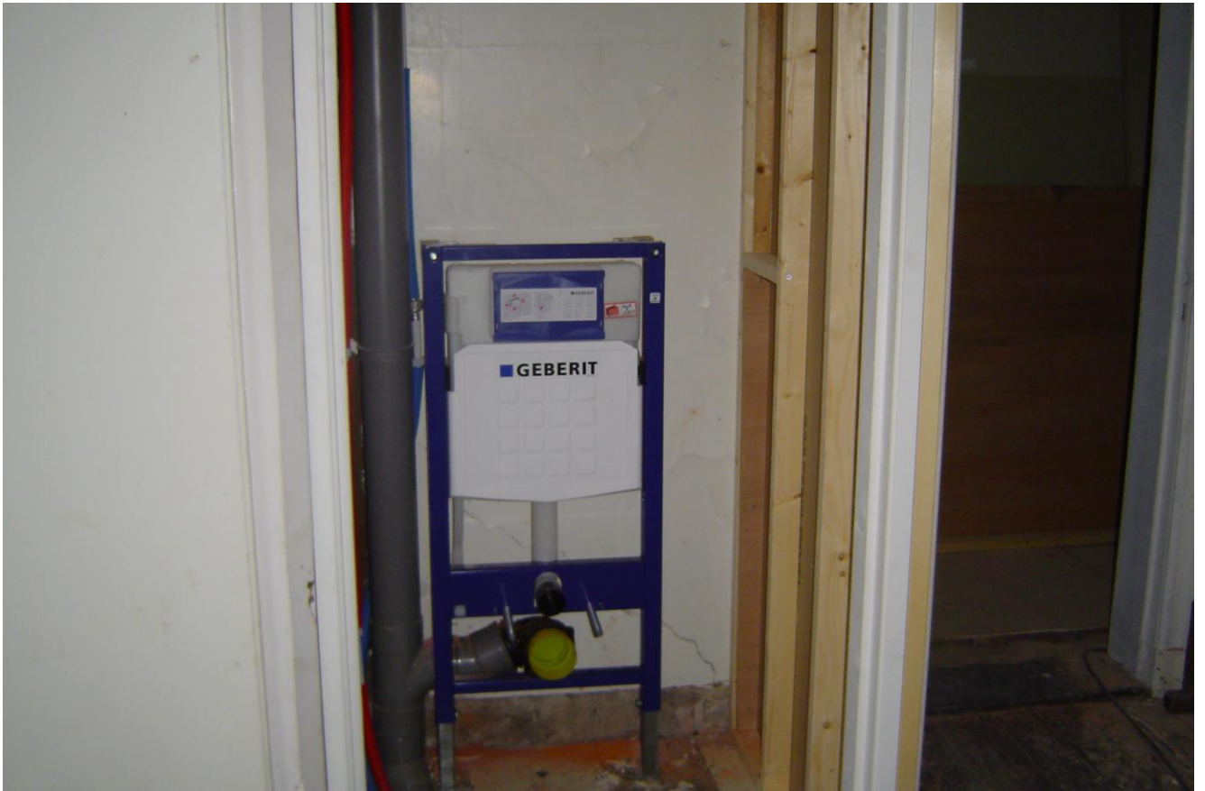
Toilet in aanbouw.
