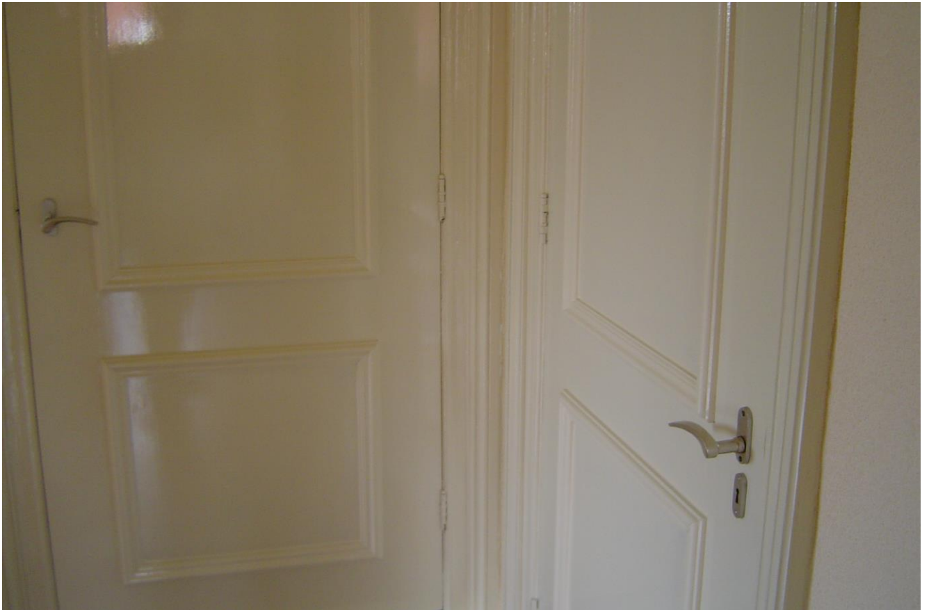
Alle deuren zijn op ouderwetse manier met de kwast geschilderd.
