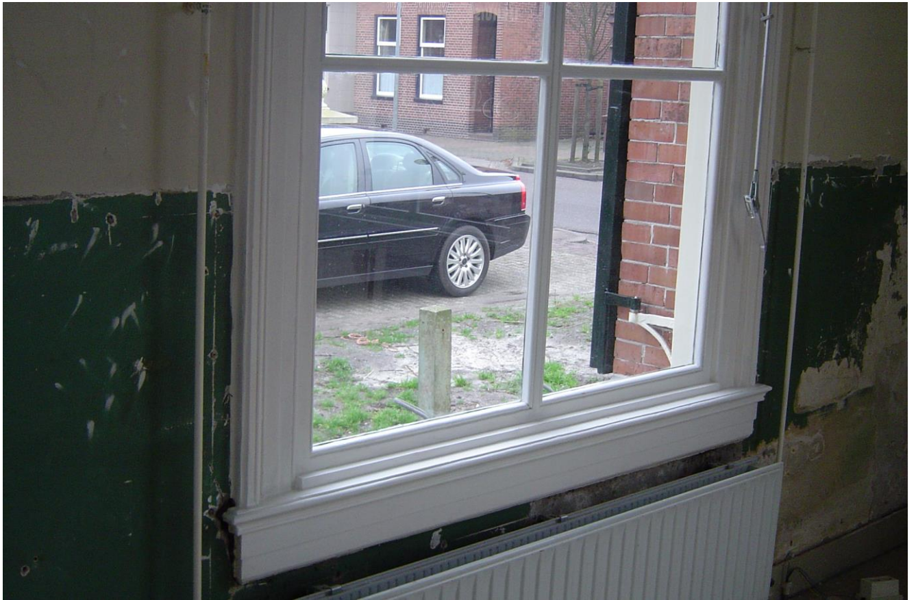
Asbest-lambrisering is verwijderd van de muren en de kozijnen staan in de grondverf.
