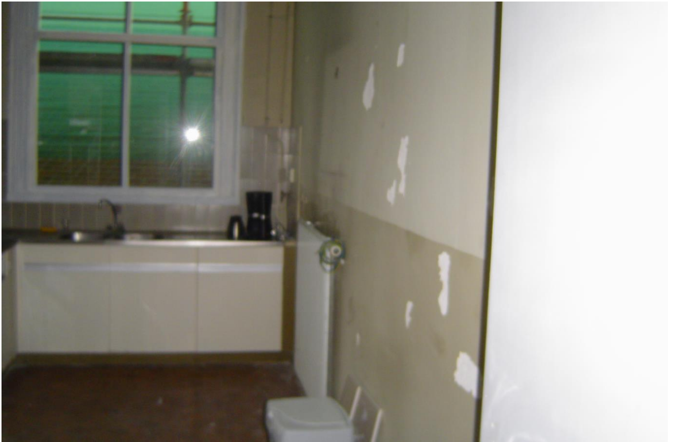
De keuken in de grondverf.
