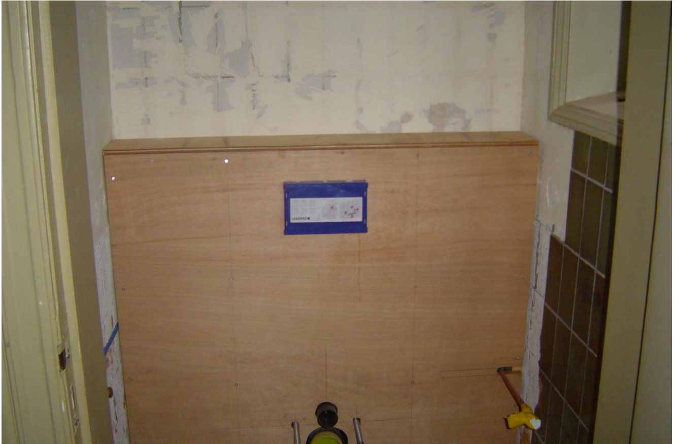
Toilet in aanbouw.
