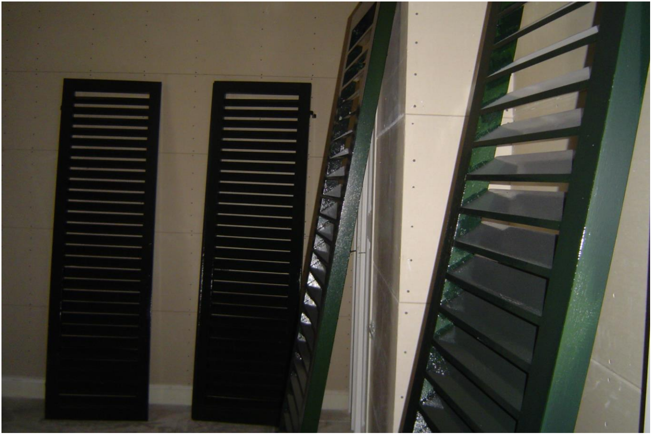
De laatste zeven ontbrekende blinden zijn bijgemaakt en worden afgeschilderd.
