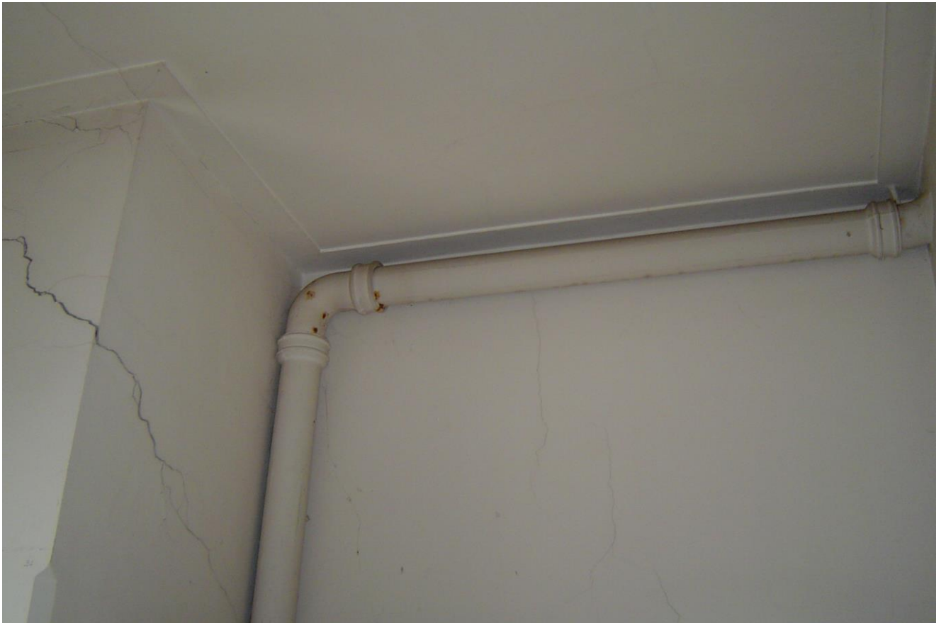
IJzeren rioleringbuis van eerste verdieping naar begaande grond.
