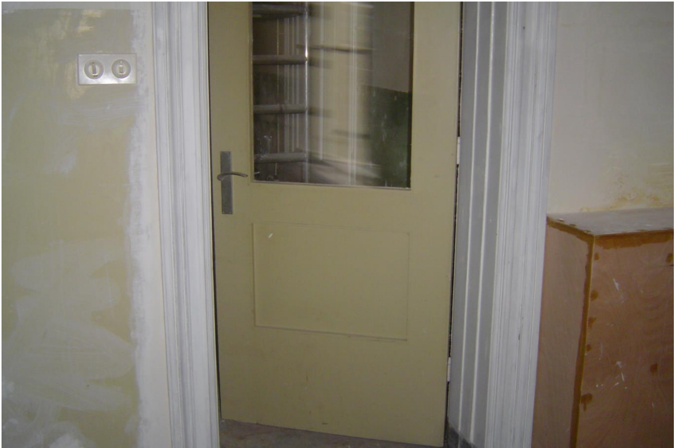
Deurkozijnen in de grondverf en de gasmeterkast afgetimmerd.
