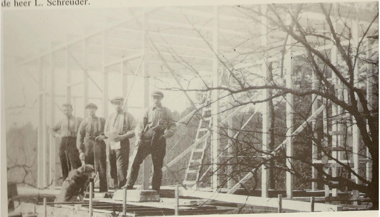
De bouw van de nieuwe school.
