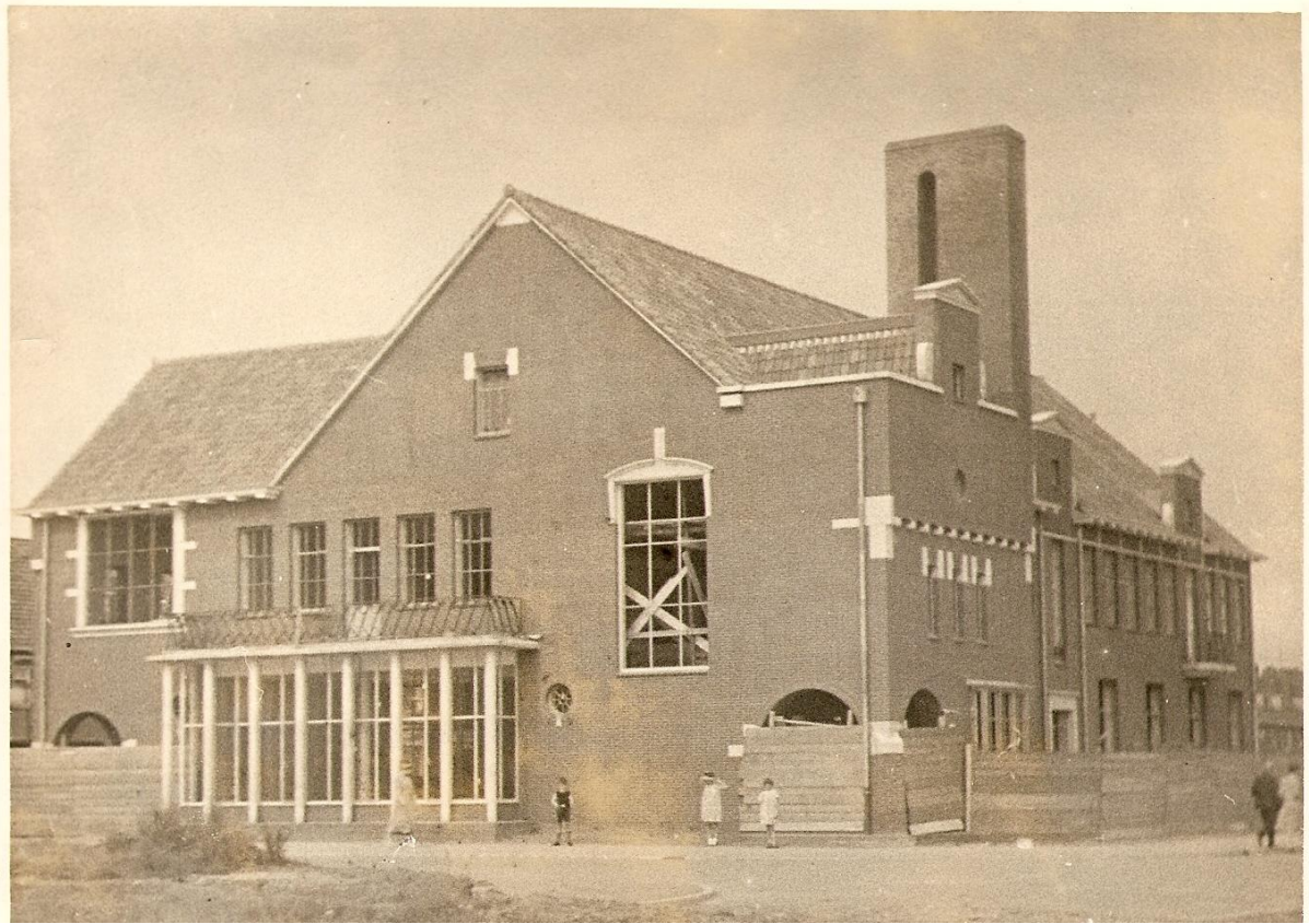
22-08-1937. Groene Kruisgebouw in Groningen. Toen nog geen bouwhekken om de bouwput, zelfs niet in de Stad. Alleen wat schuttinkjes voor de deuropeningen.
