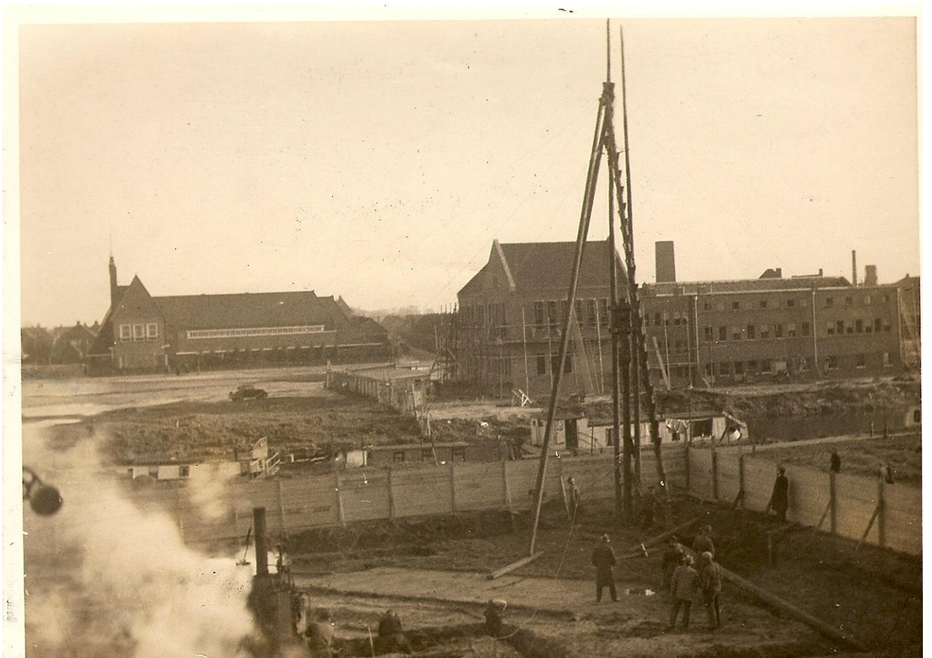
Groningen Politiebureau. Met een stoommachine werden de heipalen in de grond geheid.
