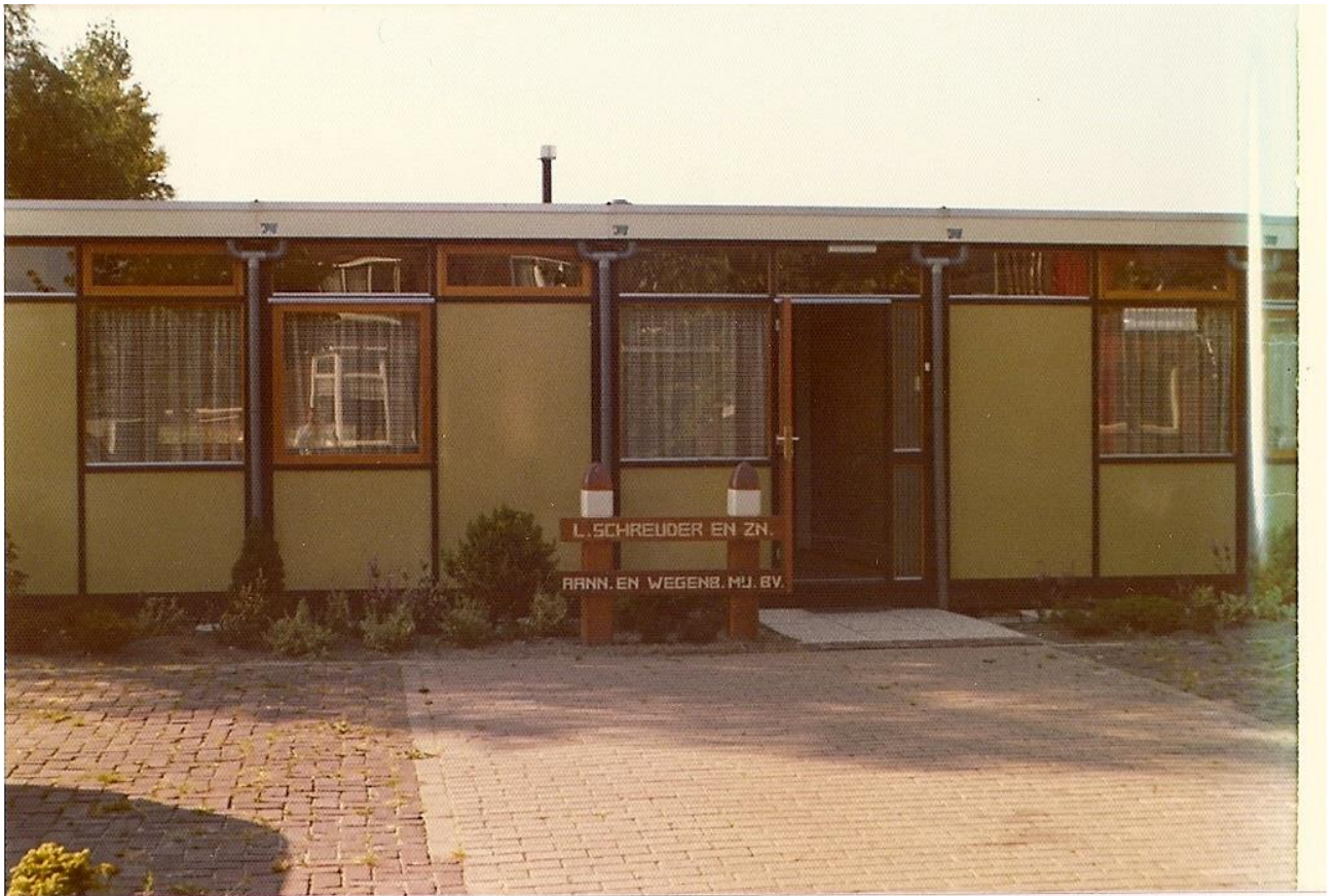
Kantoor aan de Langeleegte te Veendam
